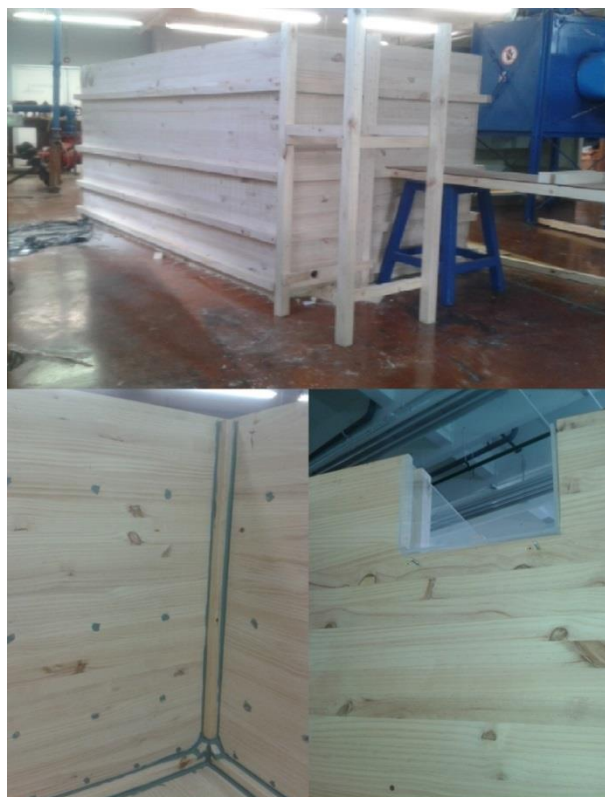
Figura 4.6. Tanque de disipación antes de ser impermeabilizado, interior (abajo).
