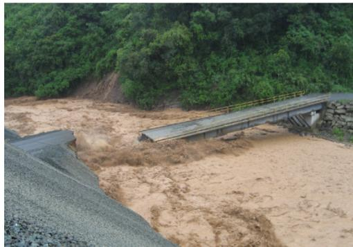
Figura 3 Erosión de la margen izquierda de puente temporal del PH Pirrís
