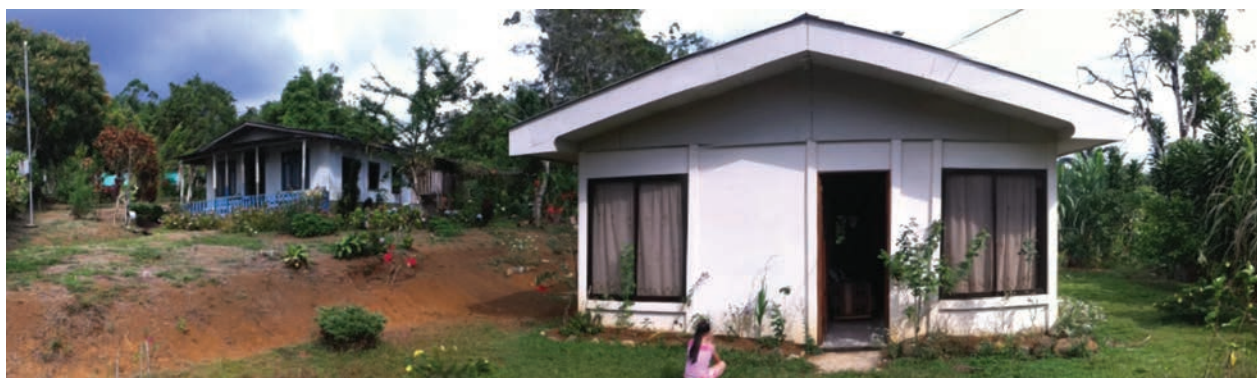
Imagen 5.37: Fotografía Panorámica de la vivienda. Fuente: Autor
