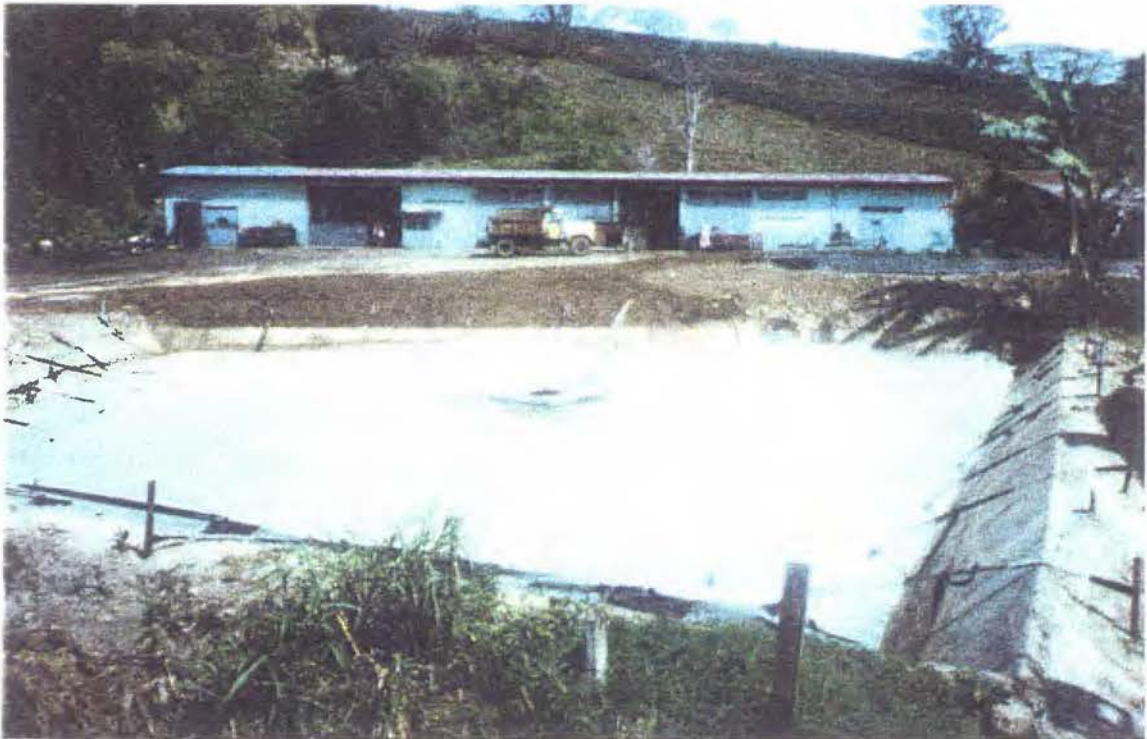
3.2.b. Bolsa de almacenamiento del agua cruda en el Beneficio Coopelibertad R.L.
