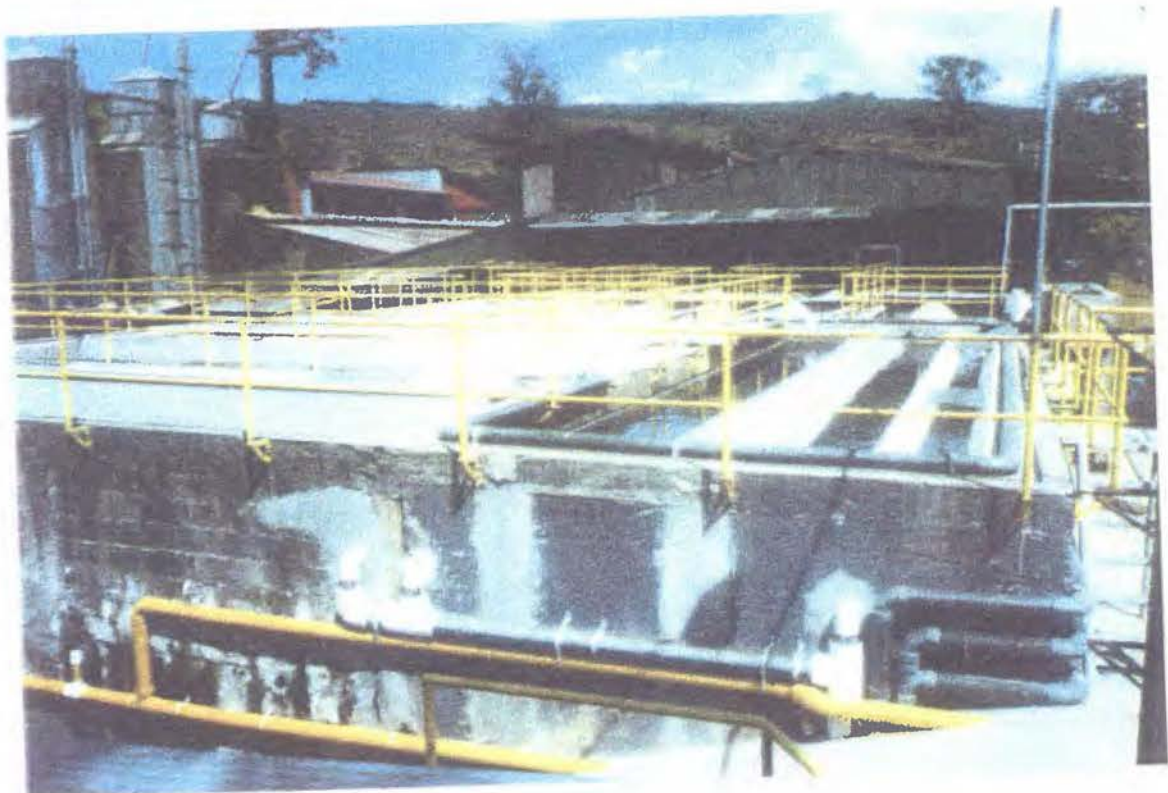
Figura 3.9.b Reactor anaerobio de mayor volumen del beneficio Coopelibertad R.L.
