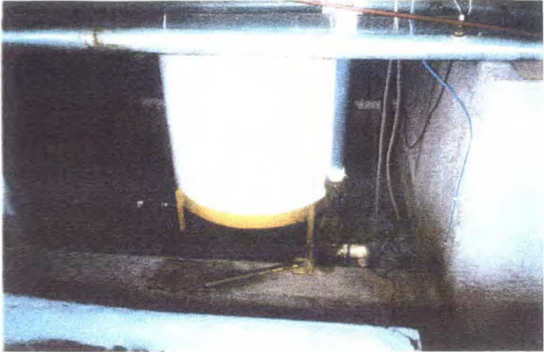
Figura 3.3.a Tanque de regulador de flujo del reactor anaerobio en el Beneficio Coopelibertad R.L.
