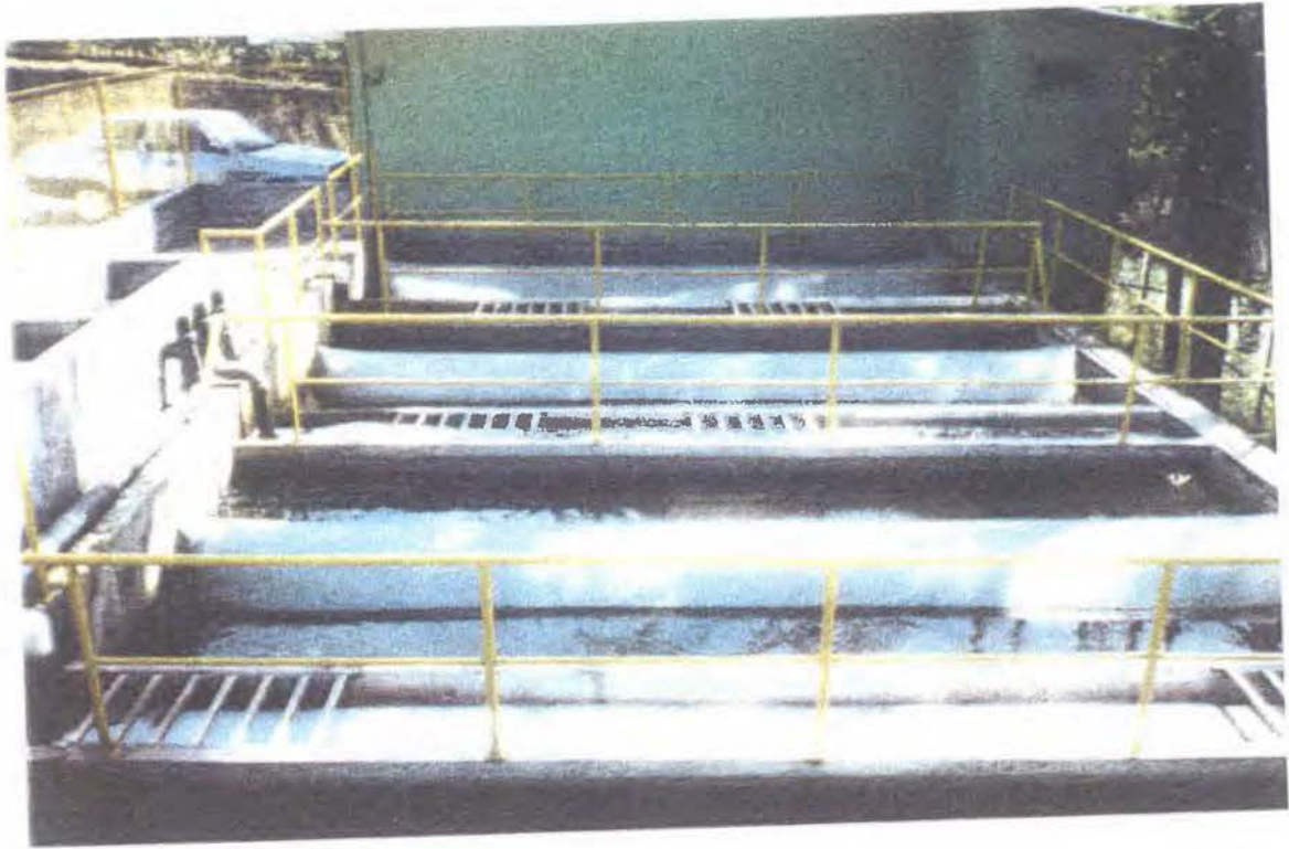
Figura 3.9.a Reactor anaerobio de menor volumen del beneficio Coopelibertad R.L
