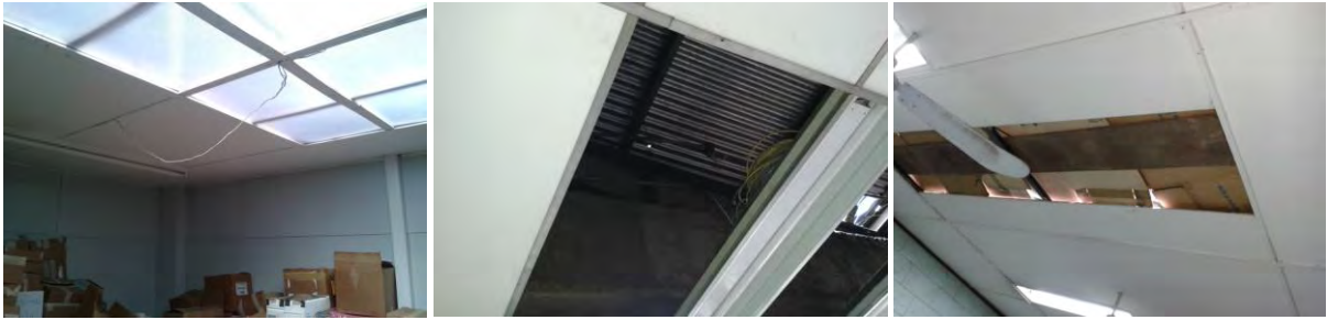
Figura 56. Cielorrasos de la DGEC.
