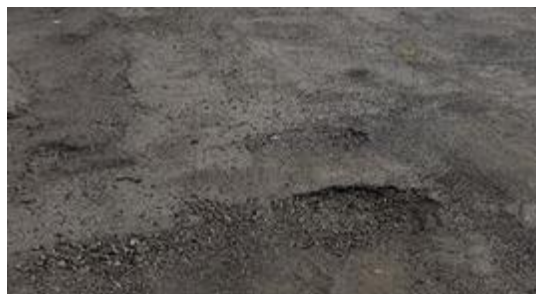
Figura 2.15. Descascaramiento.
