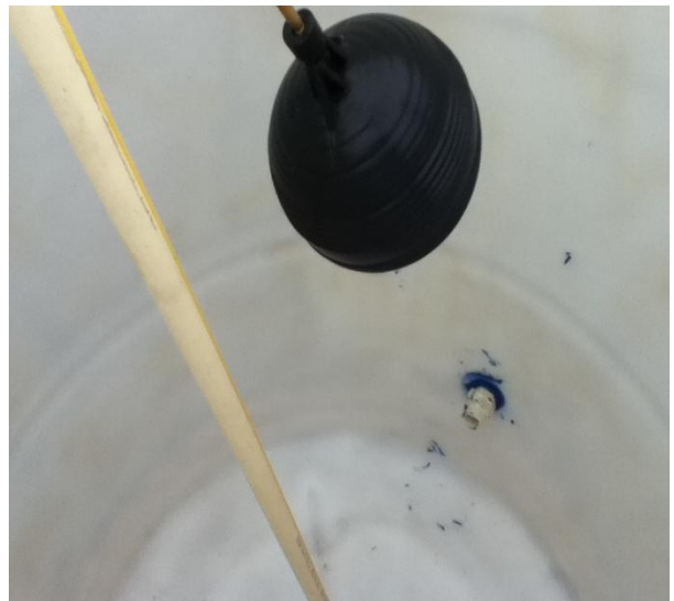
Válvula de boya dentro del tanque de almacenamiento
