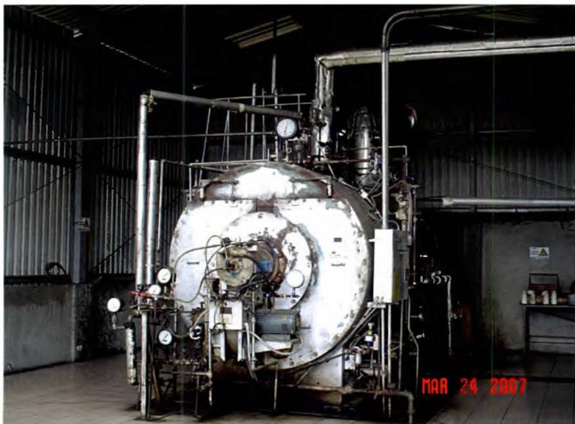
FIGURA 4.25 CALDERA IGNEOTUBULAR UB 415
