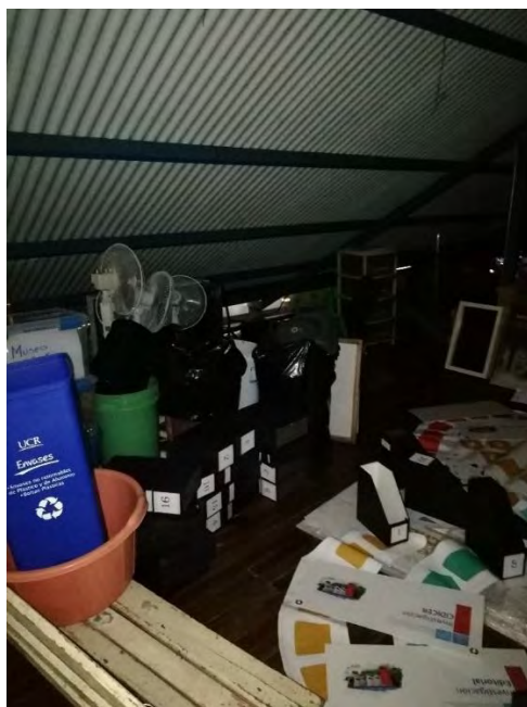
Fotografía 26 Ático usado como bodega
