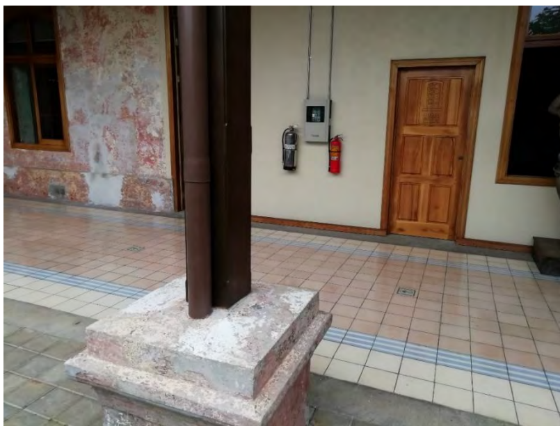
Fotografía 13 Extintores a la par del panel de control principal
