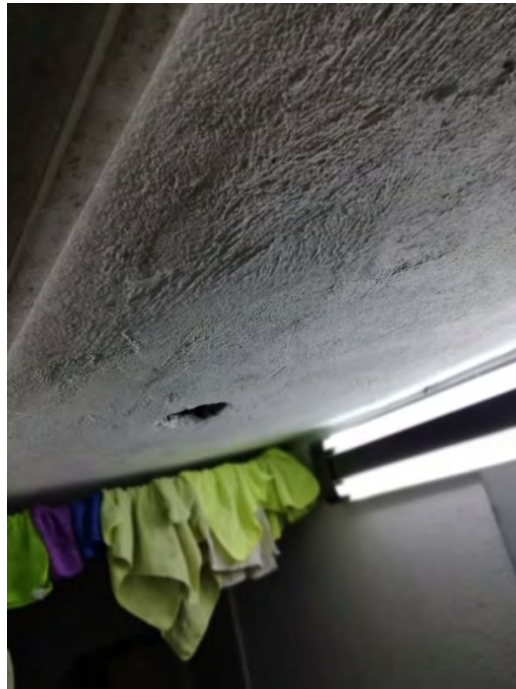
Fotografía 3 Cuarto de limpieza que esta adentro del baño de mujeres
