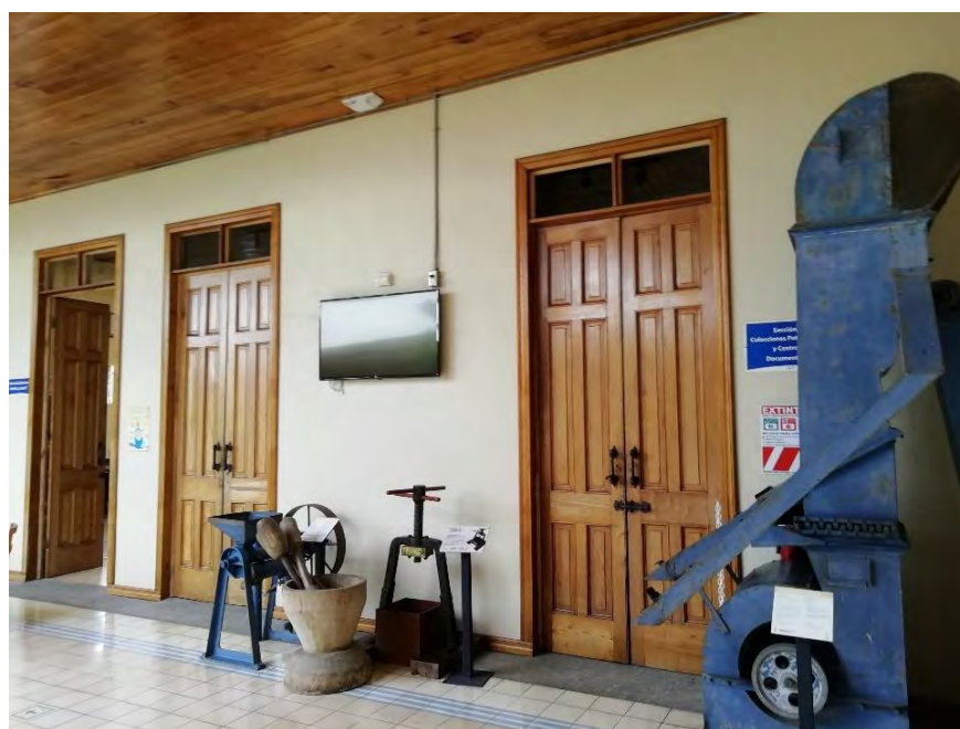
Fotografía 19 Extintor obstruido en la entrada de la sala de colecciones patrimoniales
