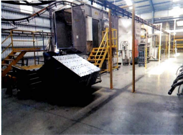
Figura 32. Estado actual estación de pintura.
