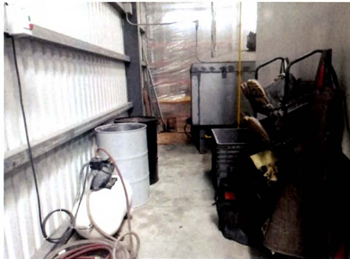
Figura 33. Estado actual almacenaje estación de pintura.
