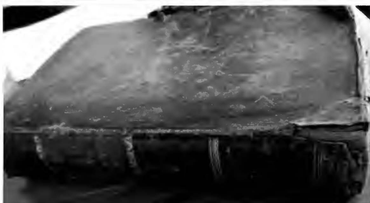
Detalle de un bisagra externa rota que abarca menos del 40% de su extensión y produce un desprendimiento parcial
