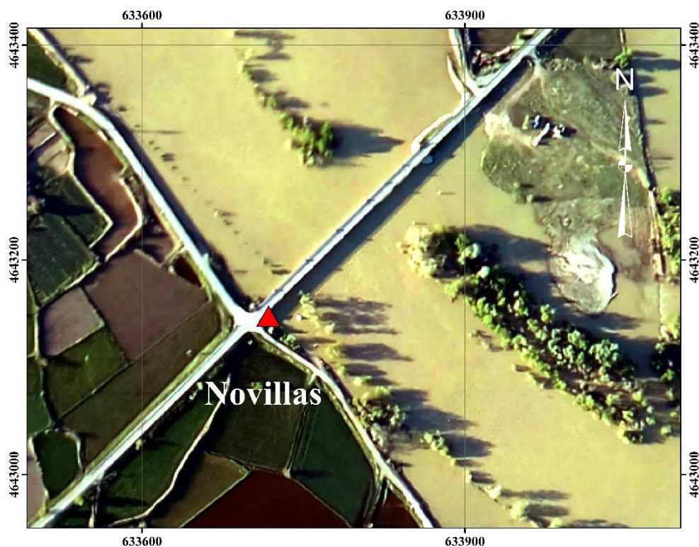
Figura 27. Ilustración puente en el que se ubica la estación de aforos Novillas.
