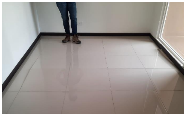
Figura 1. Levantamiento de acabados de piso debido a deflexión de losas en proyecto habitacional de la empresa que colabora con el Trabajo Final de Graduación, bajo impacto
