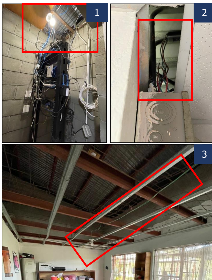
Figura 31. Ejemplos de sectores sin canalizar
