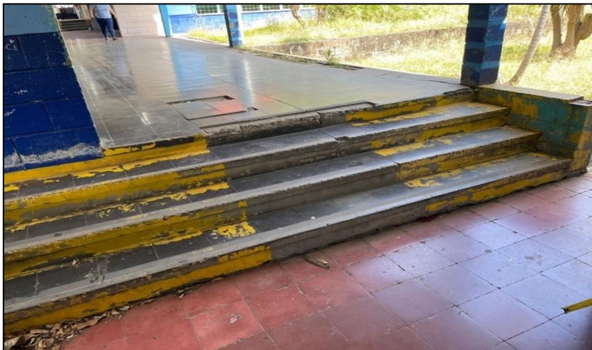
Figura 51. Escaleras entre pabellones
