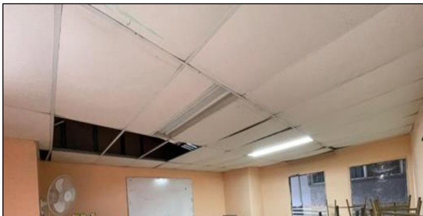
Figura 26. Deterioro físico de cielo suspendido de yeso en aula de Plan Nacional
