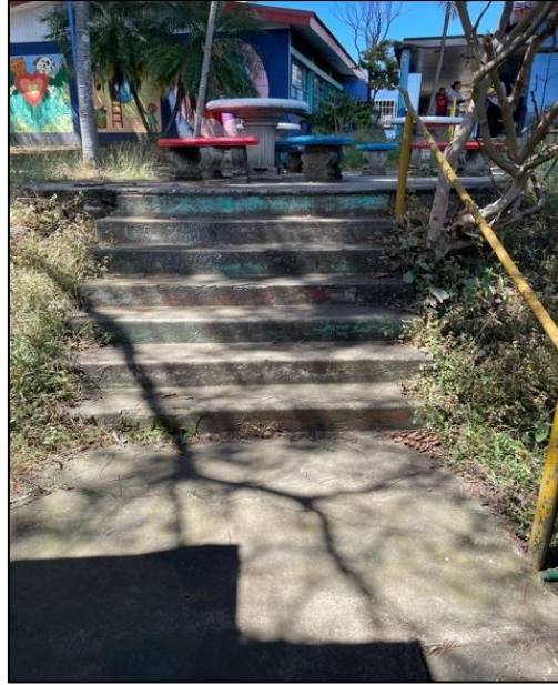
Figura 52. Escaleras con un barandal
