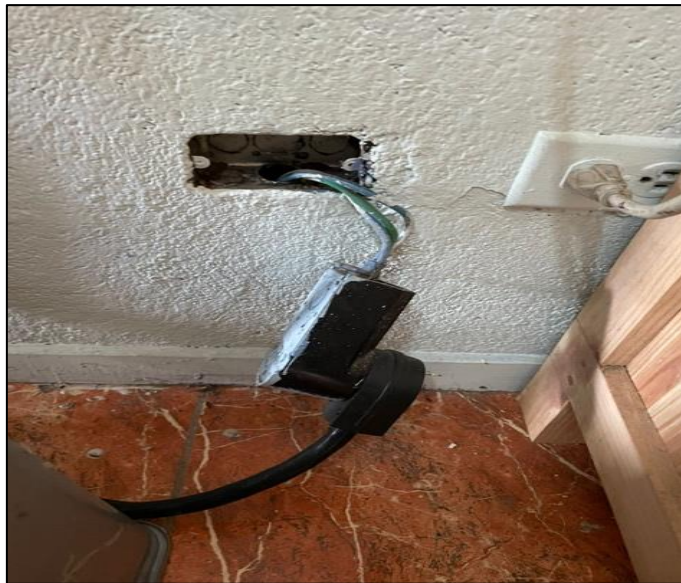
Figura 34. Tomacorriente salido
