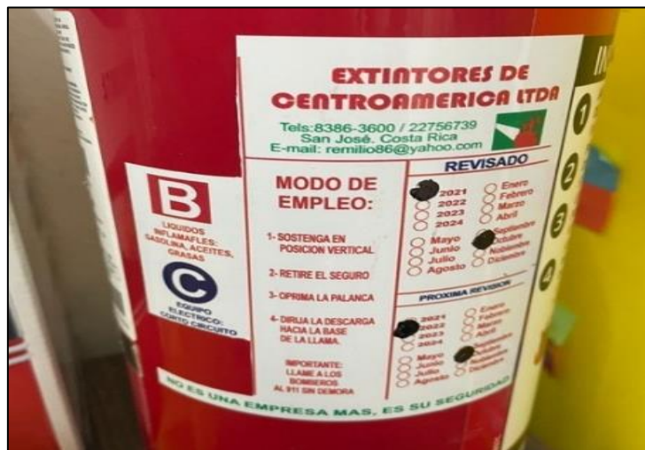
Figura 46. Extintor BC sin mantenimiento (la etiqueta muestra que fue revisado en octubre del 2021 y su próxima revisión era en octubre de 2022)
