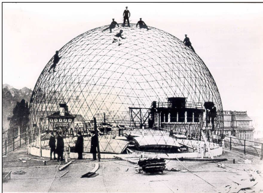
Figura 4. Construcción de domo geodésico en Jena, Alemania
