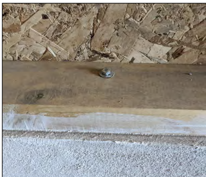
Figura 13. Anclaje típico de la estructura geodésica con el tambor de concreto
