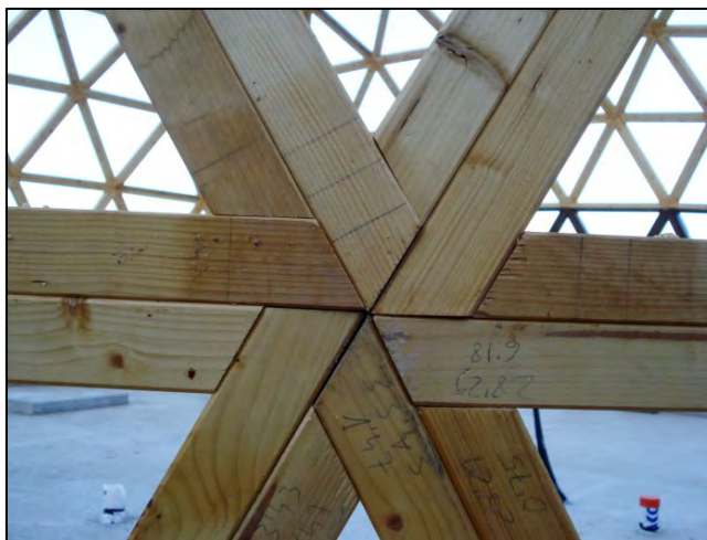
Figura 11. Unión entre triángulos por simple contacto (Tipo GoodKarma)
