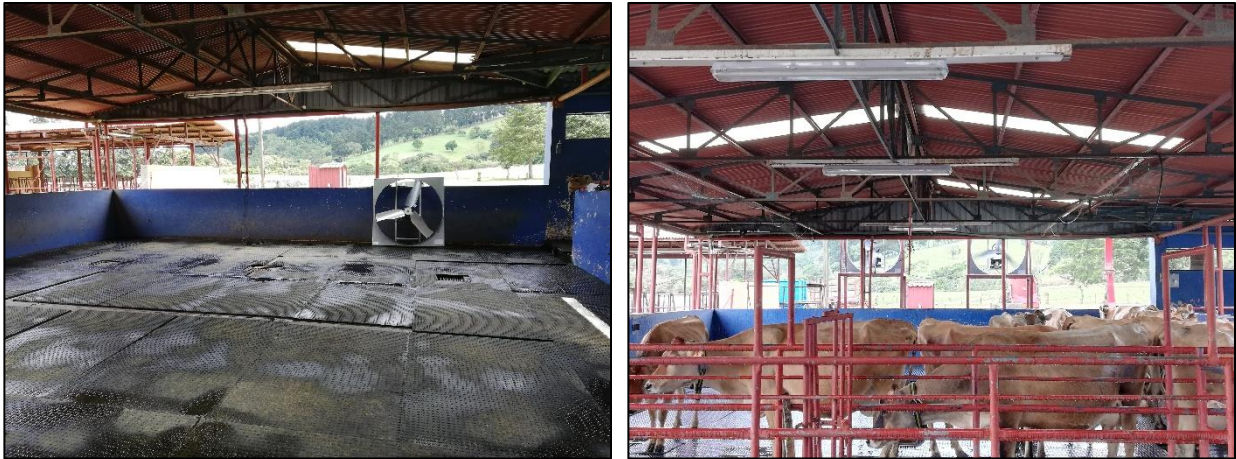
Figura 5. Sala de espera previo y posterior a la instalación del SEE
