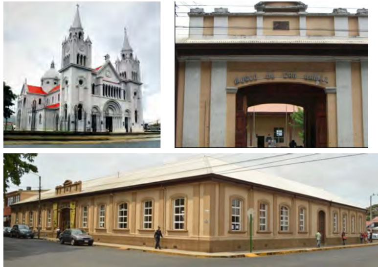
Figura 6. fotografías (2020). Detalles de la estructura del Museo Regional de San Ramón y la parroquia de San Ramón. Imágenes propias.
