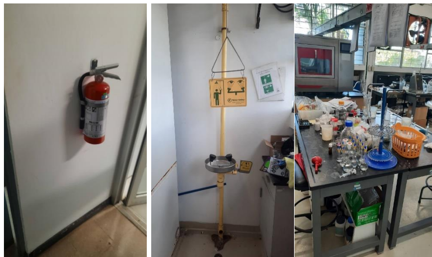
Figura E.24 Fotografías de un extintor, ducha de emergencia, lavajos y las instalaciones del laboratorio en LAYAFA.
