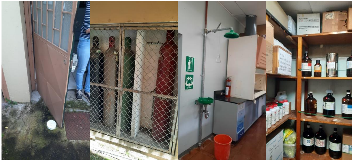
Figura E.7 Fotografías de una salida de emergencia, almacenamiento de cilindros, ducha de emergencia y almacén de reactivos del CIGRAS.
