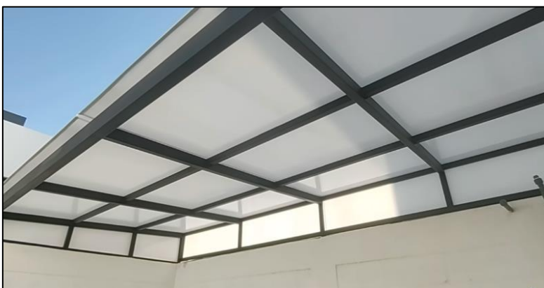
Figura 37. Ejemplo de techo con lámina de policarbonato
