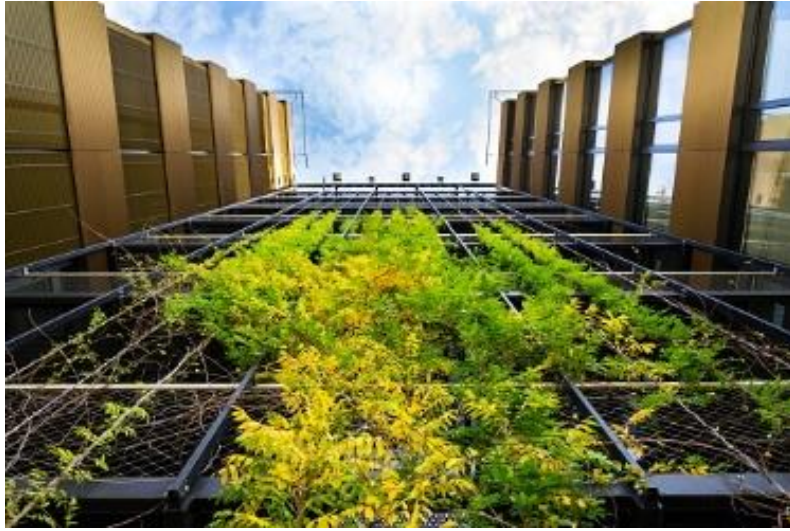
c) Ejemplo de estructura para enredaderas
