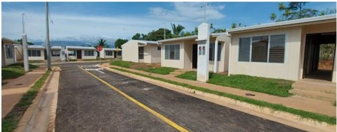
Figura 74. Viviendas construidas en proyecto Gran Sol II
