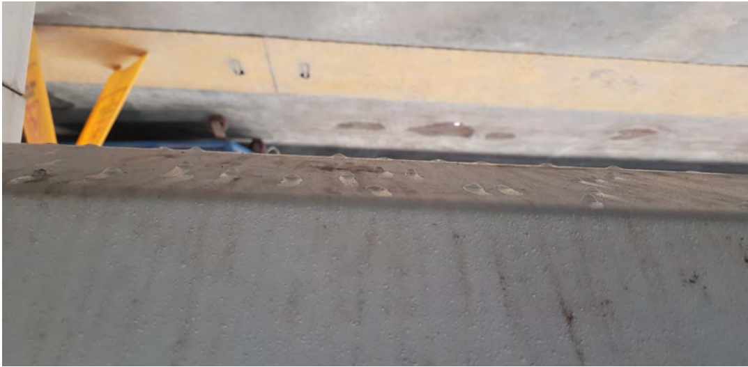
Figura 3.51. Condensación en las paredes de las tinas de enfriamiento.
