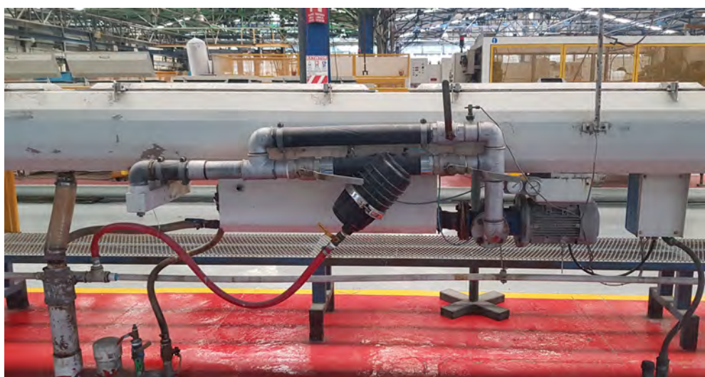
Figura 3.54. Circuito de recirculación propuesto para agua helada.
