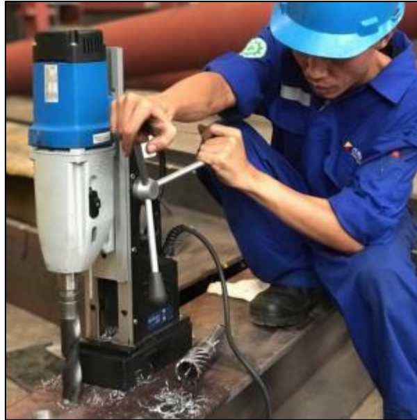
Figura 13. Uso de taladro electromagnético en perforación de vigas
