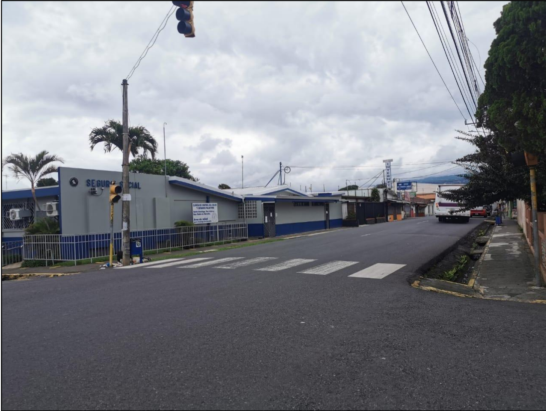
Figura 89. Fotografía actual del lugar de construcción
