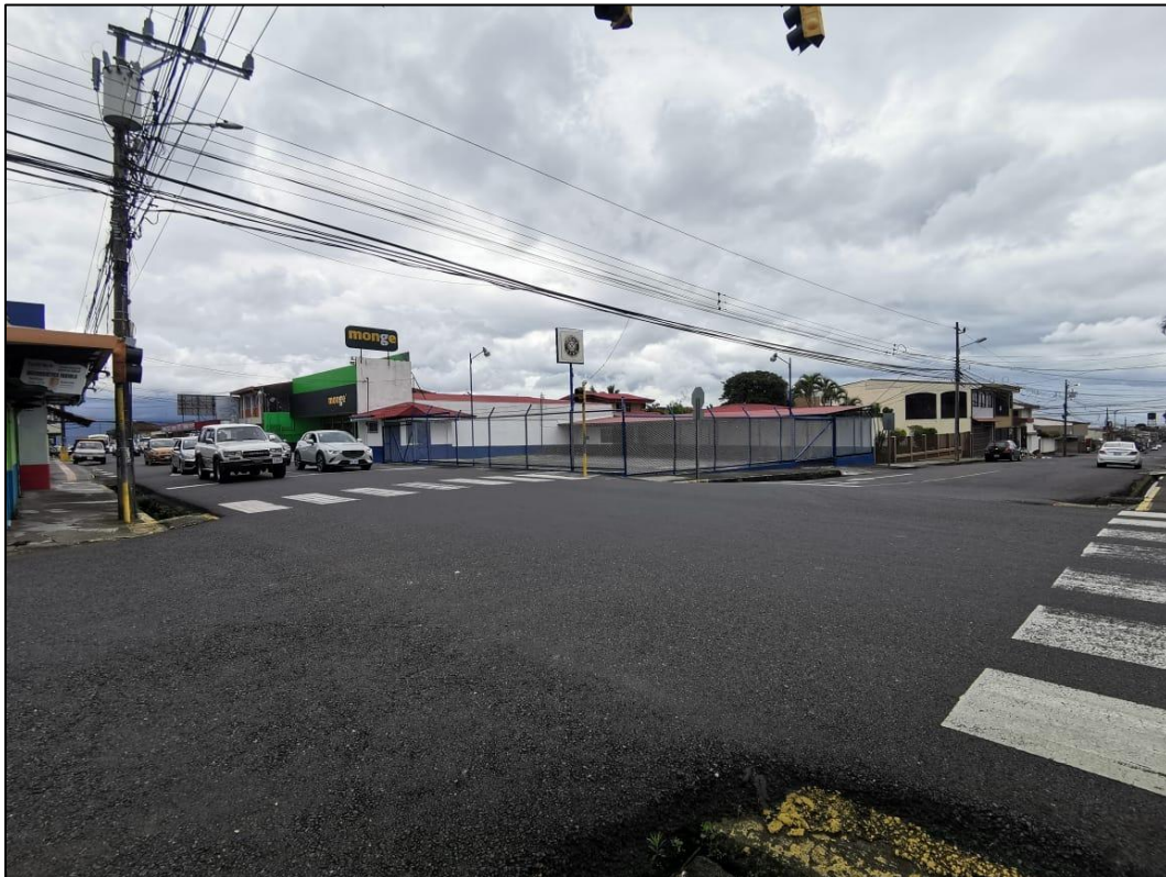
Figura 90. Espacio disponible para la construcción de bahías
