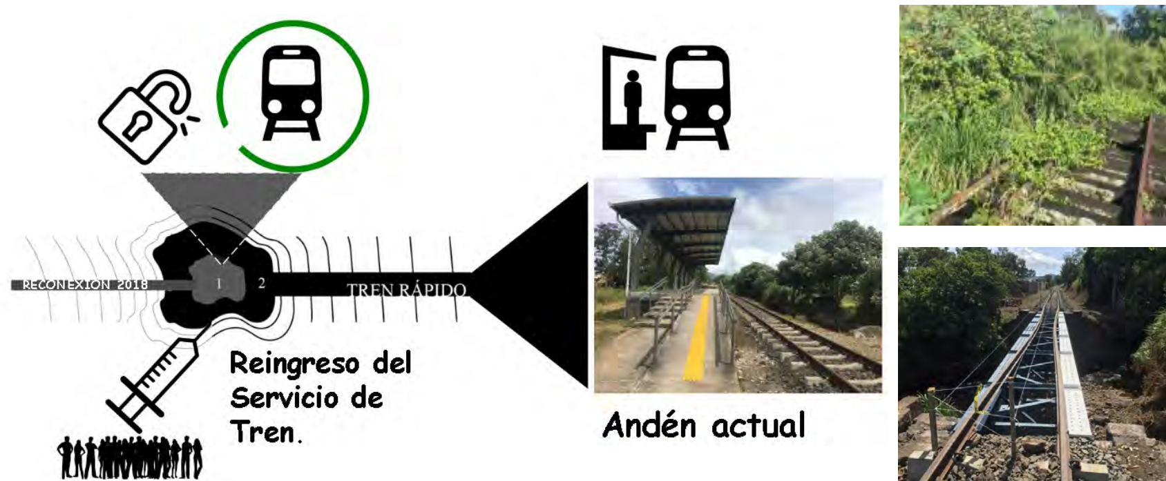
Imagen 3: Collage Puente ferroviario inicio de San Rafael. 2017.-2018 -2019.Fuente:Fernández Rodríguez, C.(2022)
