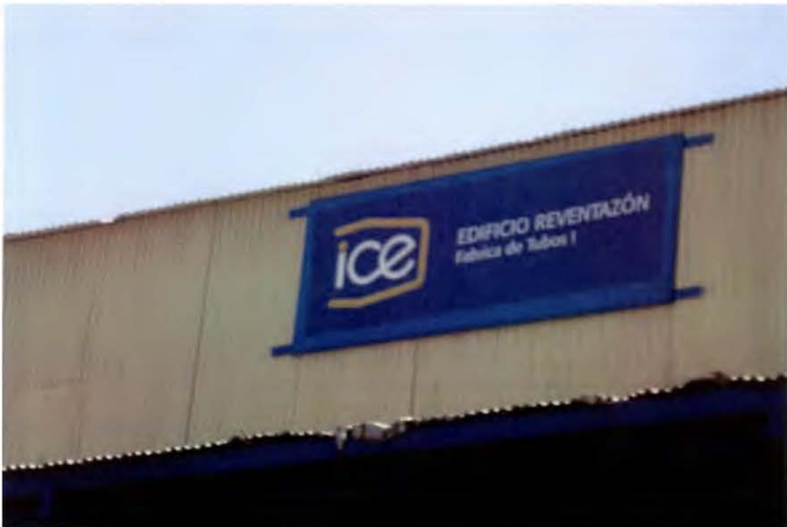
Figura 2: Fábrica de Tuberías de Alta Presión
