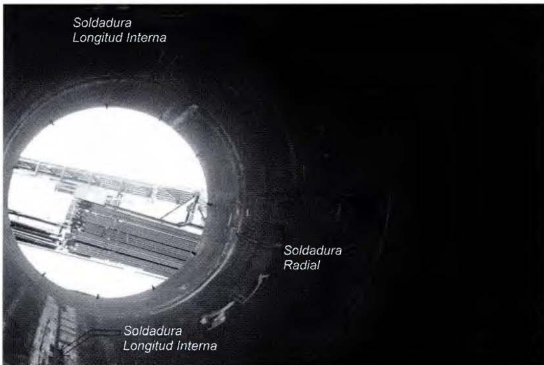
Figura 46: Imagen de tubería soldada en el sitio de trabajo
