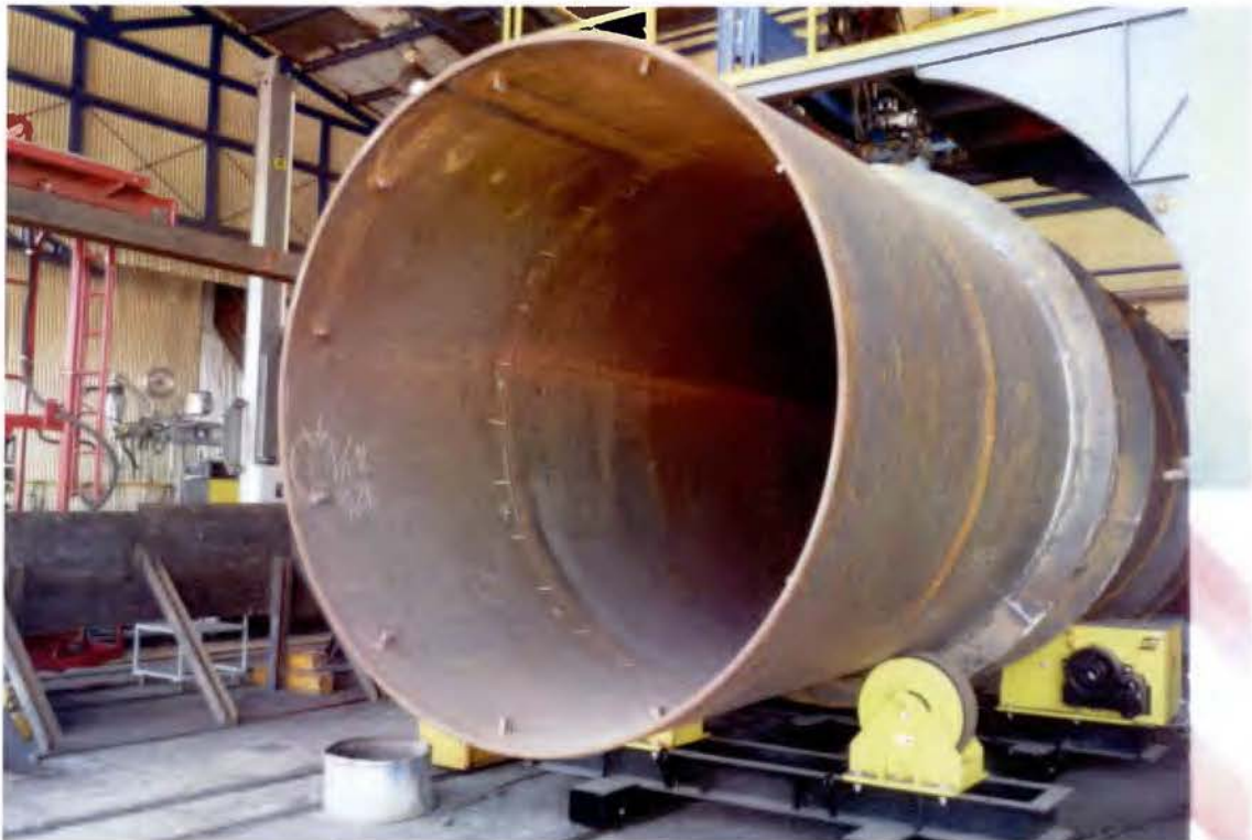
Figura 6: Fase 2, soldadura con arco sumergido
