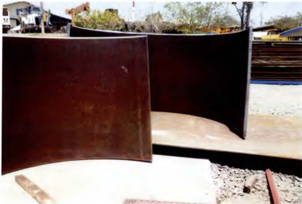
Figura 5: Perfiles laminados listos para la soldadura
