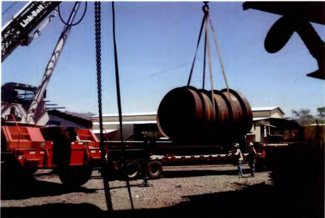
Figura 7: Transporte de segmentos de tubería soldada
