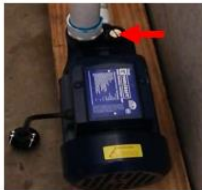
Figura E.7. Tornillo para verificar que la bomba está llena de agua.
