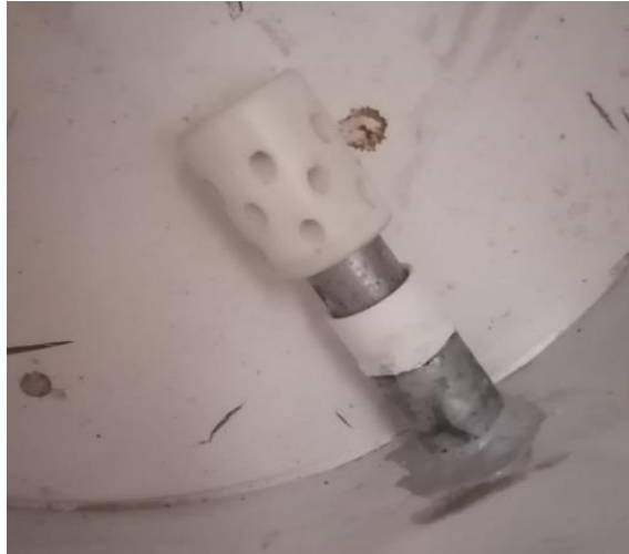
Figura 2.19. Detalle de la protección para los aspersores.
