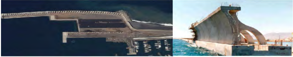
Figura 2.23: Dique con espaldón ubicado en el Puerto Tazacorte, Málaga, España. Fuente [Negro and et al., 2017]
