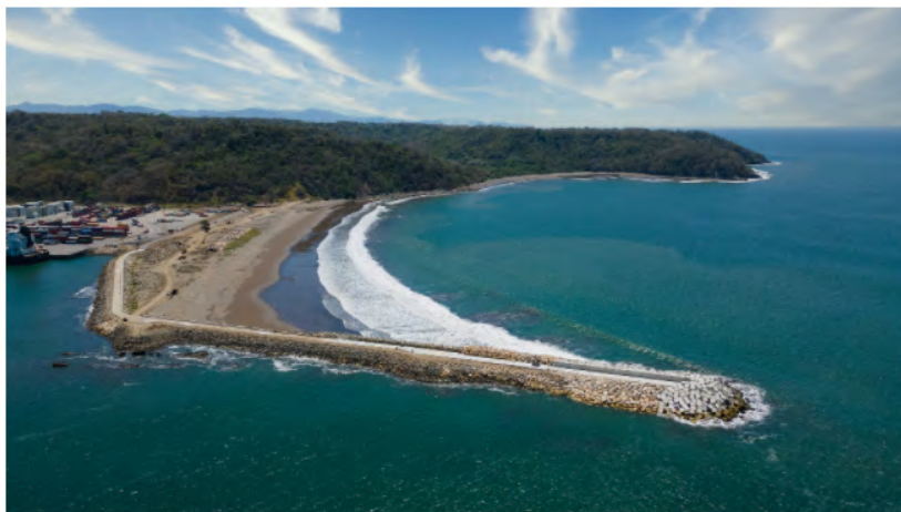
Figura 2.21: Dique Mixto ubicado en Puerto Caldera, Puntarenas, Costa Rica. Fuente:[Rica, 2021]
