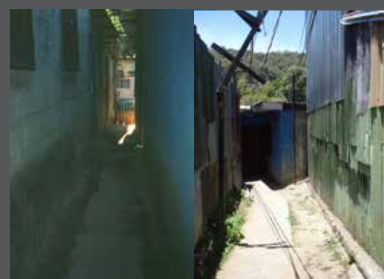
IM.66. Imágenes de cuarterías al fondo de callejones no vistos desde la calle principal en el barrio Cuatro Calles en Pinos del Este.
