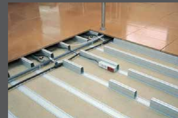
IM.33. Los pisos registrables son ejemplo de detalles de diseño que permiten la flexibilidad de los espacios.
