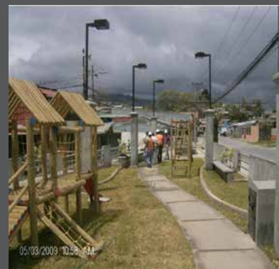
IM.17. Fotografías antes y después de uno de los proyectos de la Fundación Costa Rica Canadá en el Sector 1 en Los Guido, Desamparados.
