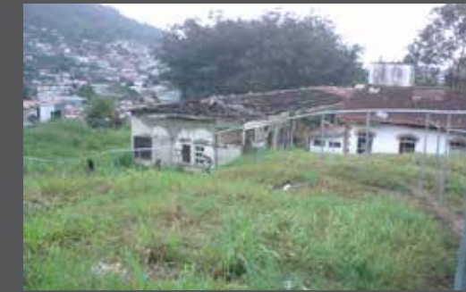
IM.42. Fotografía del 2009 cuando se cerró con malla el terreno del CTP Uladislao Gámez, se observa el edificio histórico del Asilo Las Mercedes hoy ya restaurado para el colegio.
