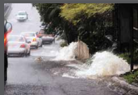
IM.65. En esta imagen se aprecia uno de los problemas por la falta de alcantarillado pluvial en el sector.
