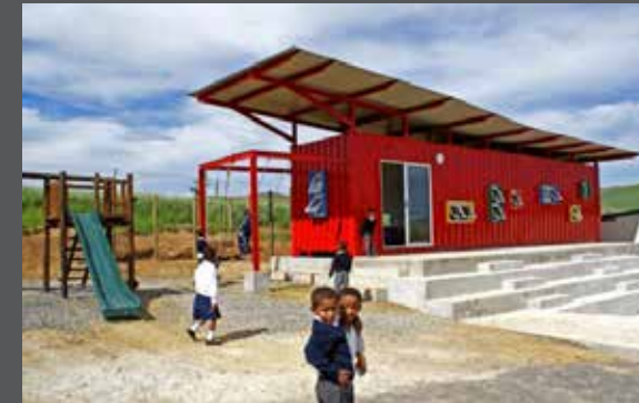
IM.31. Uno de los principales ejemplos de infraestructura flexible es la utilización de contenedores modificados, que se transportan completos al sitio y se adaptan al contexto.
