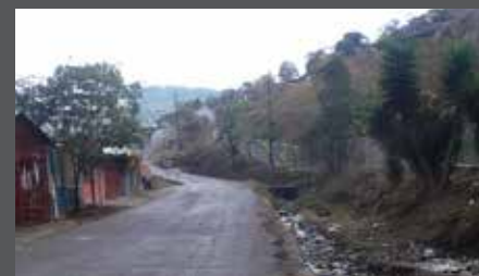
IM.81. El borde del relleno Sanitario se presta para focos de contaminación y espacios residuales.
