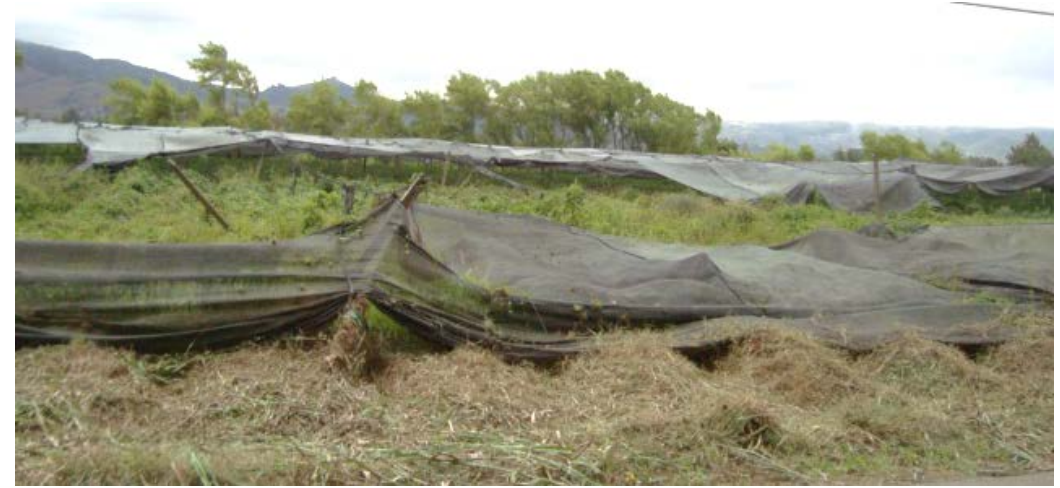
Imagen 34: Lotes en estado de abandono, ubicados en El Guarco, Cartago
