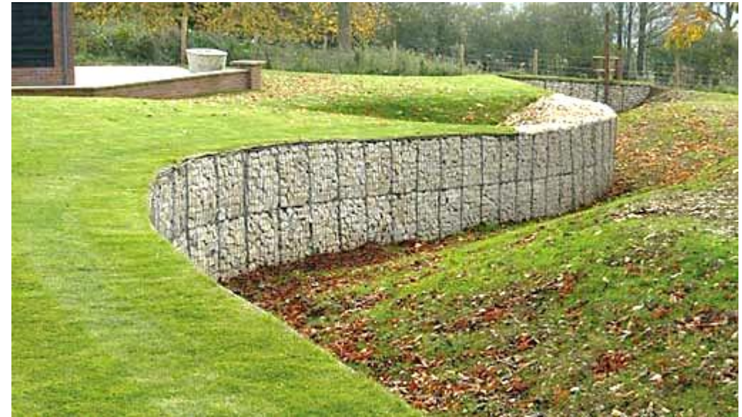
Imagen 47: Gaviones para el paisaje y la estabilización en High Wycombe.
