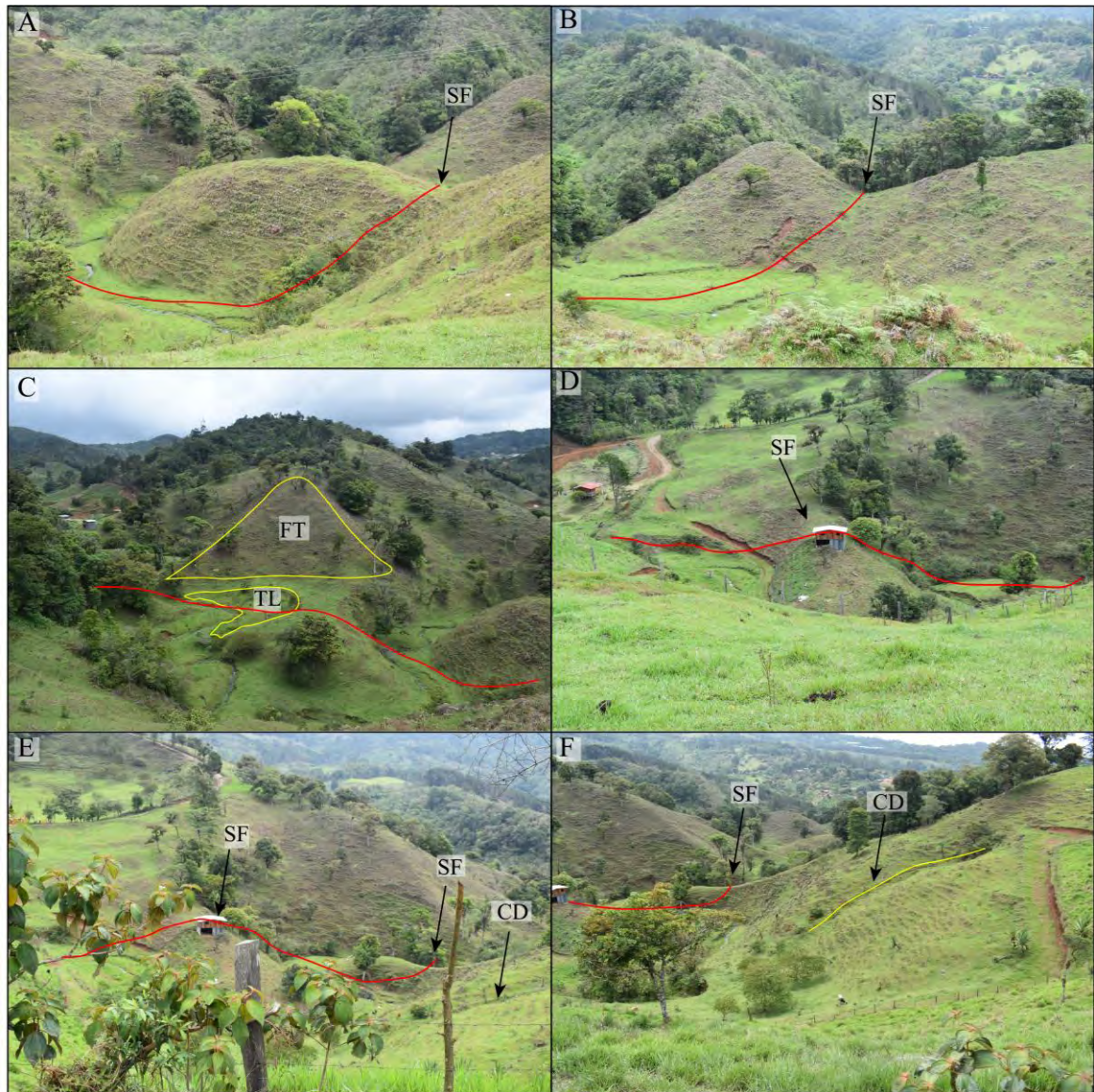
Figura 19. Marcadores geomorfológicos asociados al lineamiento de la falla Navarro (trazo rojo). A) Silla de falla (SF), visto desde S5 en Figura 17. B) Silla de falla (SF), visto desde S5 en Figura 17. C) Faceta triangular (FT) y terraza aluvial levantada (TL), visto desde S5 en Figura 17. C) Silla de falla (SF) visto desde S5 en Figura 17. E) Silla de falla (SF) y quebrada descabezada (CD), visto desde S5 en Figura 17. F) Silla de falla (SF) y quebrada descabezada (CD), visto desde S5 en Figura 17 (coordenadas 1080875,117N/503632,430E).
