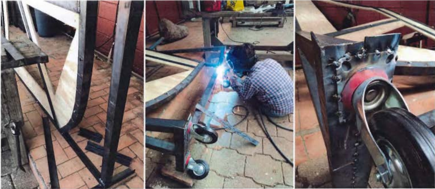
Figura 45: Soldado de las patas y colocación de los rodines
