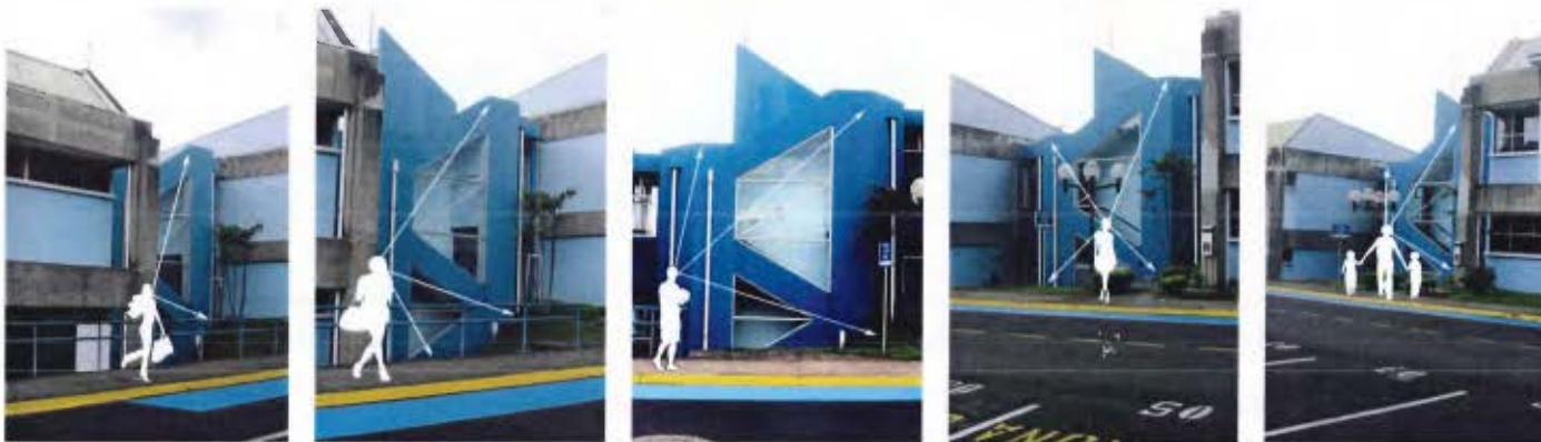
Figura 5: Edificio del CIPRONA con vistas posibles para un transeúnte de izquierda a derecha durante el día
