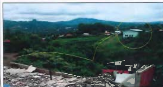
Figura 12. Cimentaciones situadas a media ladera, salón comunal de Rincón de Alpizar
