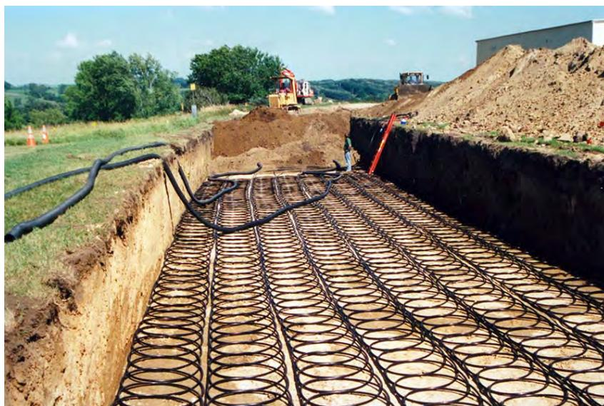
Figura 3.13: Circuito cerrado de configuración horizontal tipo *slinky*. Fuente: [67]
