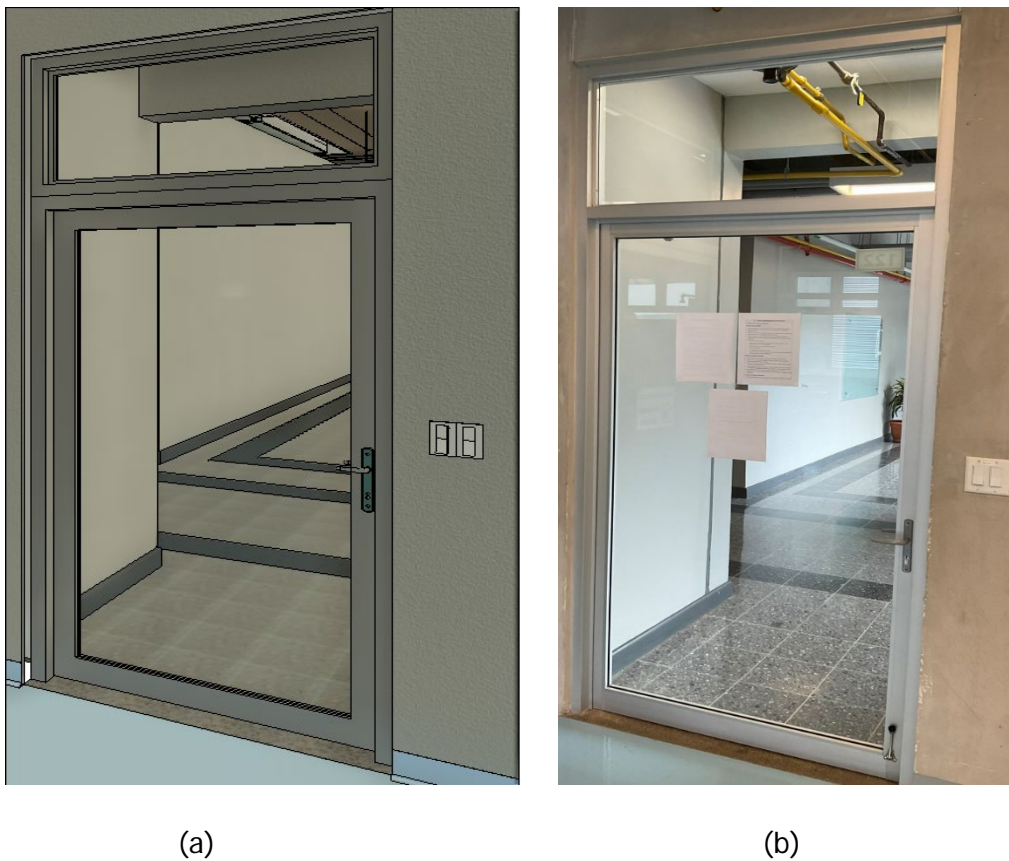
Figura 34. Comparación entre puerta modelada (a) y puerta instalada (b)
