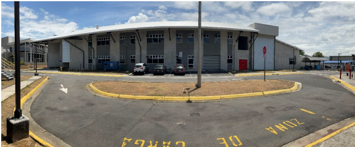
Figura 16. Fotografía de la fachada oeste del edificio
