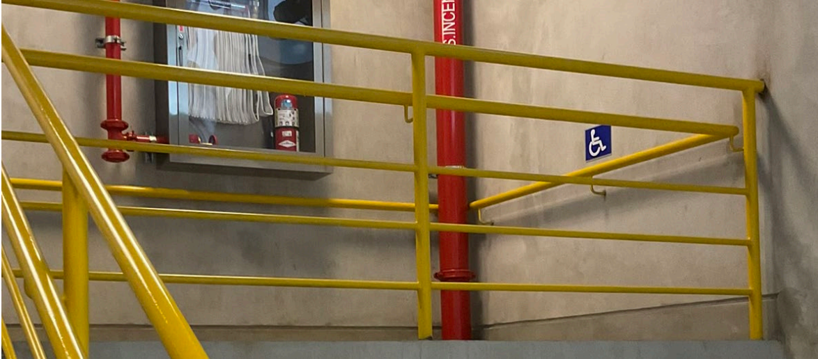
Figura 26. Fotografía: Barandillas ubicadas en las escaleras del edificio
