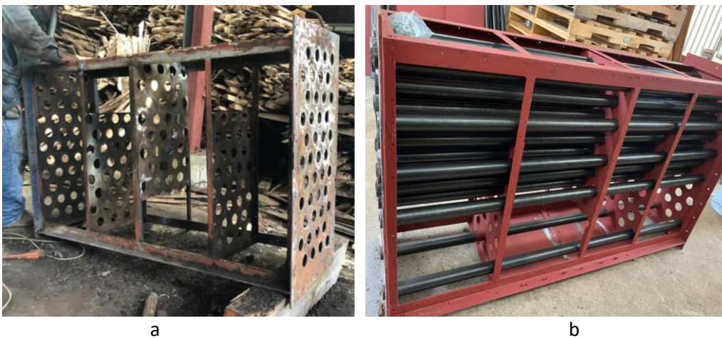
Figura 3.5. a. Detalle de la coraza con deflectores b. Coraza reparada en proceso de colocación de tubos.
