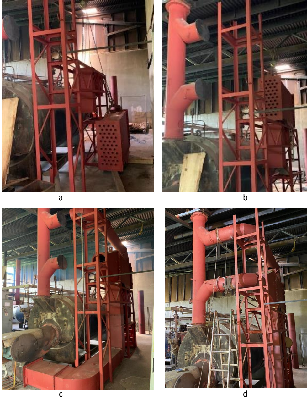
Figura 3.8. a) Montaje del ventilador y el intercambiador, b) detalle de tapas en el distribuidor y alineado del intercambiador, c) colocación de la embocadura y espejo trasero del intercambiador, d) acople de ductos de gases de combustión con el distribuidor de gases.
