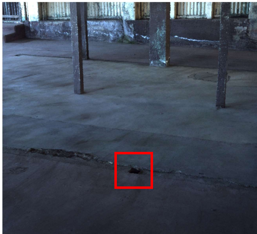
Figura 55. Muestra de columnas faltantes
