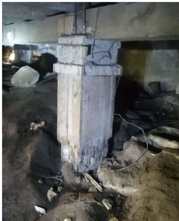
Figura 79. [cc, 12c] no se retiró la formaleta
