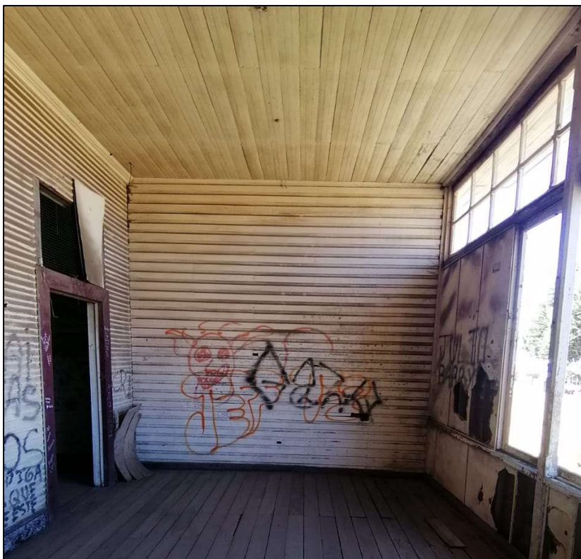
Figura 35. Acabados en paredes, puertas y ventanas
