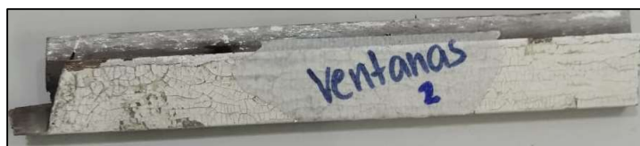
Figura 36. Muestra de madera en marcos en ventanas y puertas
