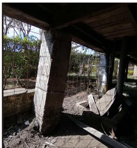
Figura 80. [ec, 1c] columna con inclinación
