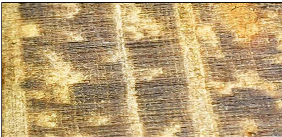
Figura 21. Muestra de madera en las vigas
