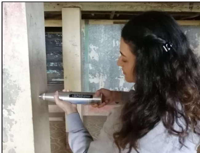
Figura 26. Prueba con esclerómetro en columnas
