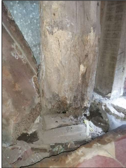
Figura 77. Columna [gm, 19m],: pudrición en la base
