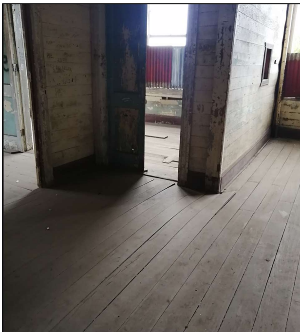
Figura 85. Piso asentado en primer nivel
