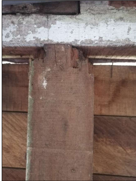
Figura 73. Columna [sm, 22m]: rebajo de esquina
