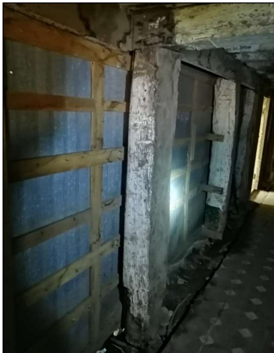
Figura 75. Columna [gm, 22m],: pudrición en la base
