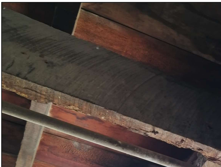
Figura 68. Viga [s-q,8]: ataque de insectos
