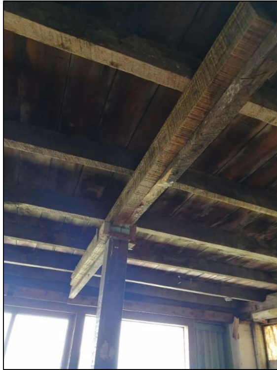
Figura 69. Viga [s-n,3]: calza y agregado
