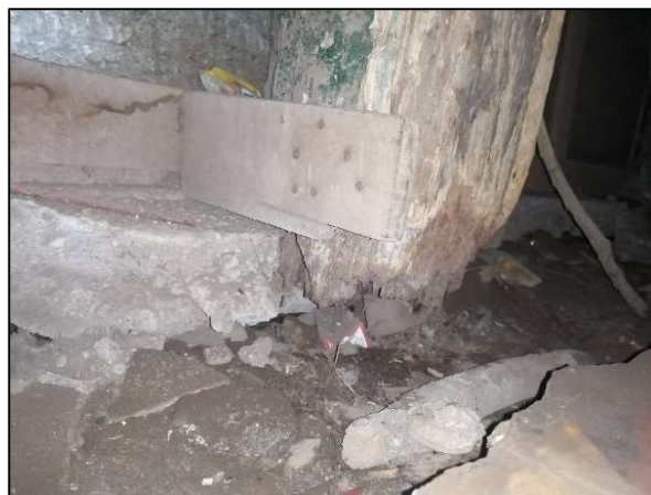
Figura 76. Columna [gm, 22m],: pudrición en la base
