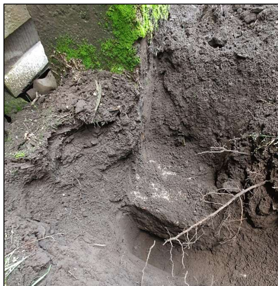
Figura 47. Excavación en placa de cimentación
