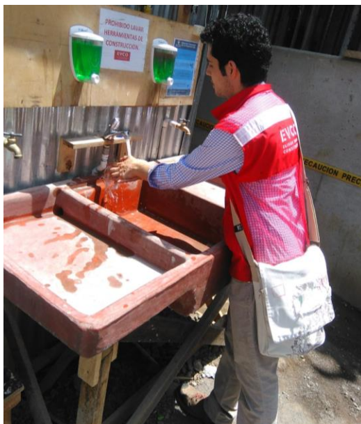
Figura 32. Empleo de llaves tipo "push" en lavatorios del proyecto Torre Las Loras
