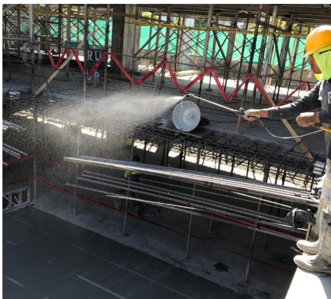
Figura 59. Aplicación de curador químico para concreto en proyecto San Pedro Business Center
