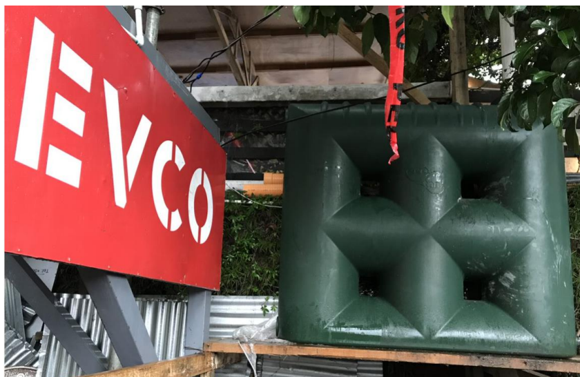
Figura 62. Tanque utilizado para la recolección de agua de lluvia en el proyecto San Pedro Business Center
