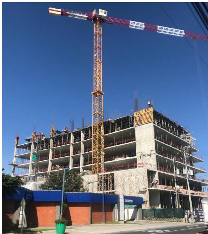
Figura 57. Fotografía del proyecto San Pedro Business Center en su etapa de construcción
