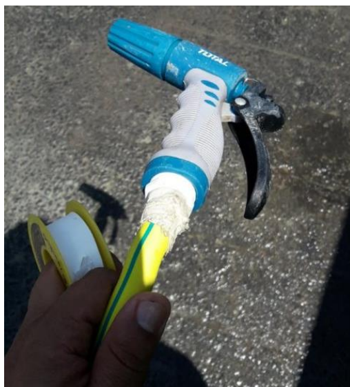
Figura 29. Manguera reparada y con pistola para evitar y controlar el desperdicio de agua
