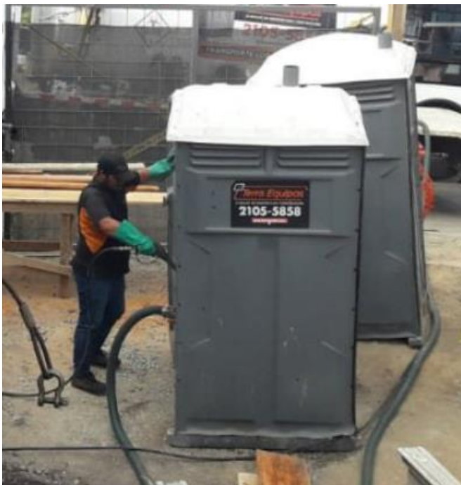
Figura 34. Limpieza de cabañas sanitarias del proyecto Torre Las Loras
