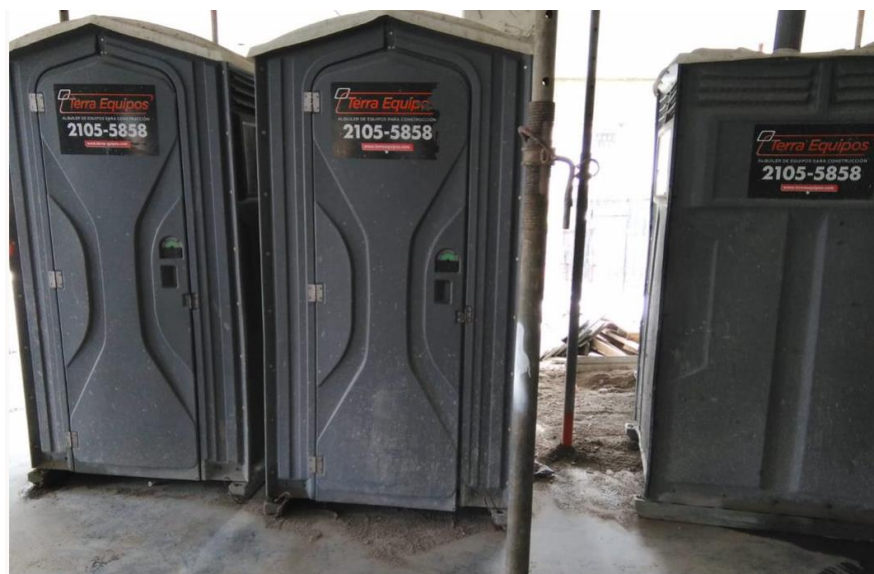
Figura 33. Cabañas sanitarias utilizadas en el proyecto Torre Las Loras
