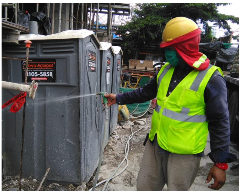
Figura 60. Aplicación de curador químico para concreto en proyecto San Pedro Business Center
