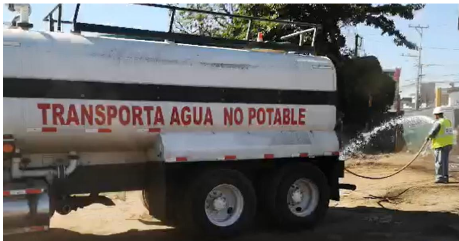
Figura 61. Empleo de tanquetas para el control del polvo en el proyecto San Pedro Business Center
