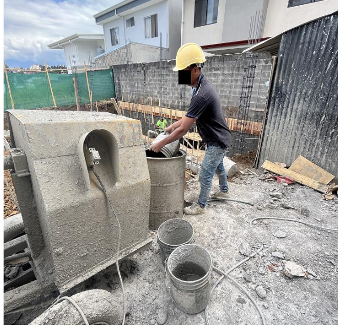
Figura 23. Forma en la que se recolecta el agua para dosificar en el concreto hecho en obra
