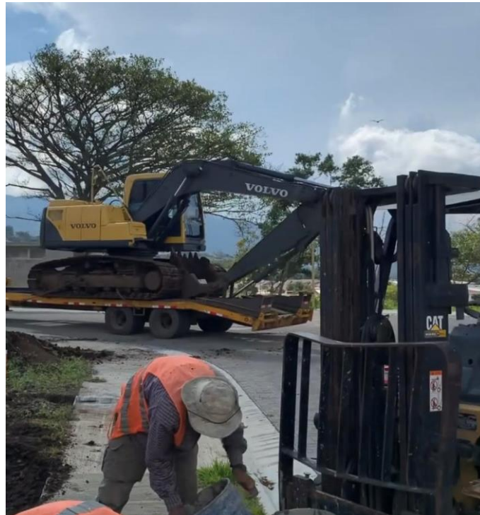
Figura 12. Retroexcavadora utilizada en proyecto 1
