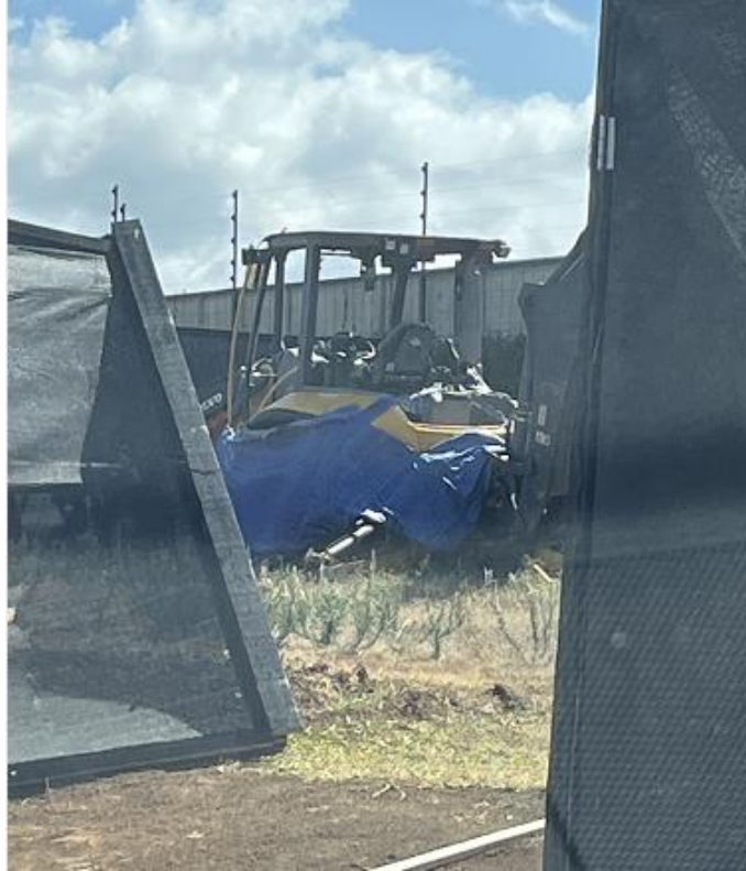
Figura 13. Retroexcavadora utilizada en proyecto 2
