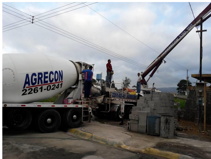
Figura 14. Camión mezclador y bomba típicas de la empresa AGRECON
