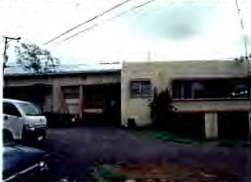
Imagen 5.3 Oficinas de agentes de seguridad Centro de Atención Institucional el Buen Pastor
