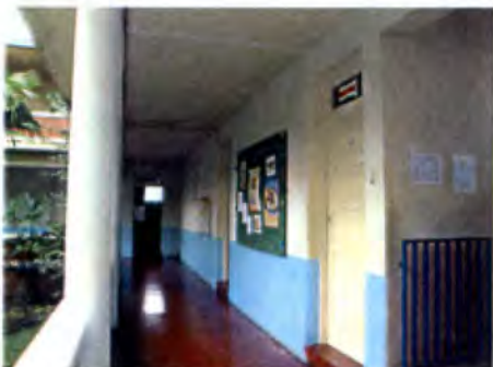
Aulas de UNED, ubicadas en el edificio de Oficinas administrativas
