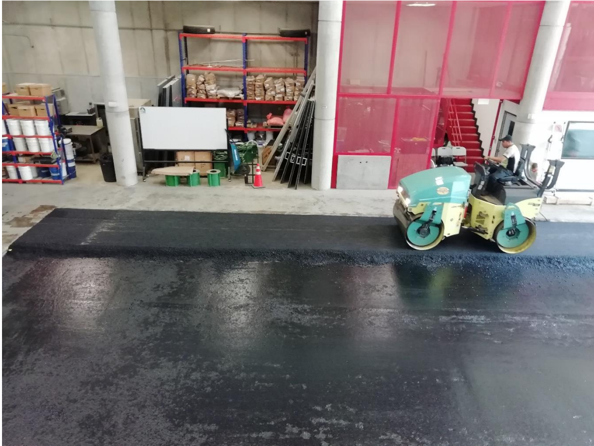
Figura 54. Etapa de compactación en la construcción de los tramos en el LanammeUCR (Foto tomada por Gabriela Cerdas el 20 de setiembre, 2019)
