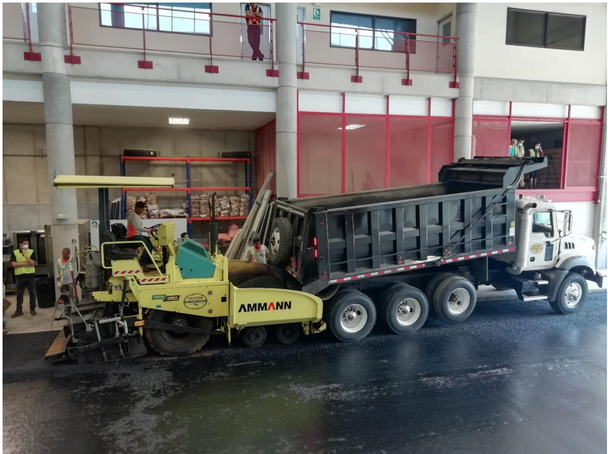
Figura 53. Etapa de pavimentación en la construcción de los tramos en el LanammeUCR (Foto tomada por Gabriela Cerdas el 20 de setiembre, 2019)
