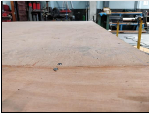
Figura 82. Pandeo de láminas de madera contrachapada
