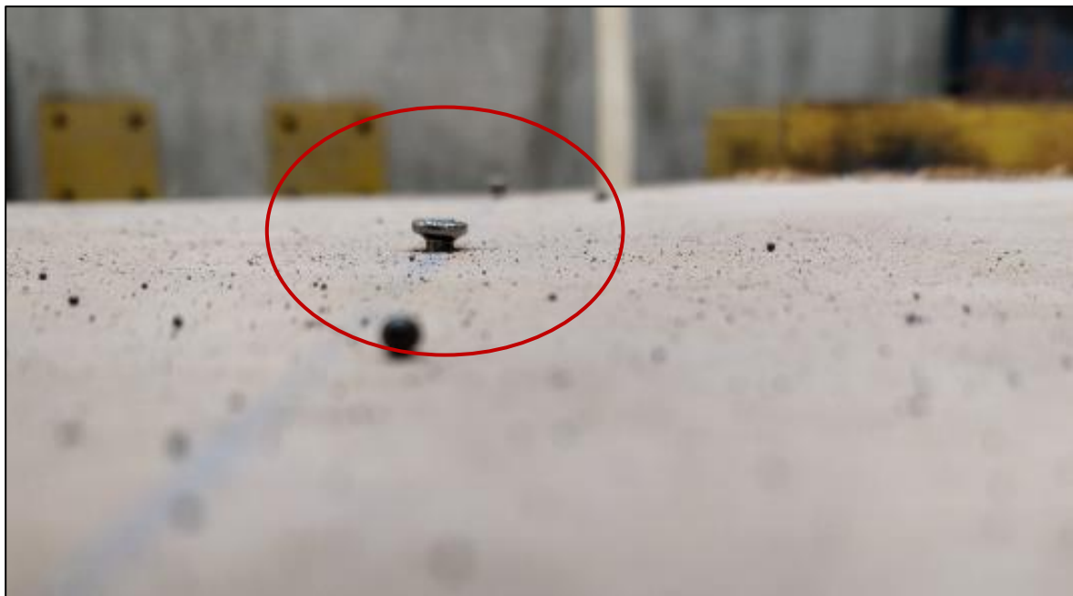
Figura 80. Falla por cortante en D2
