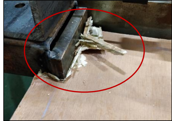
Figura 79. Falla en apoyo D2
