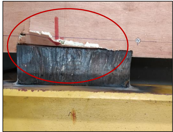
Figura 75. Punto de carga posterior a la falla
