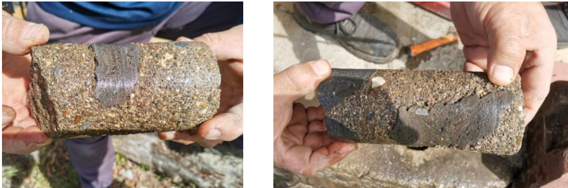
Figura 20. Núcleos de concreto extraídos Especímenes E1 y E2
