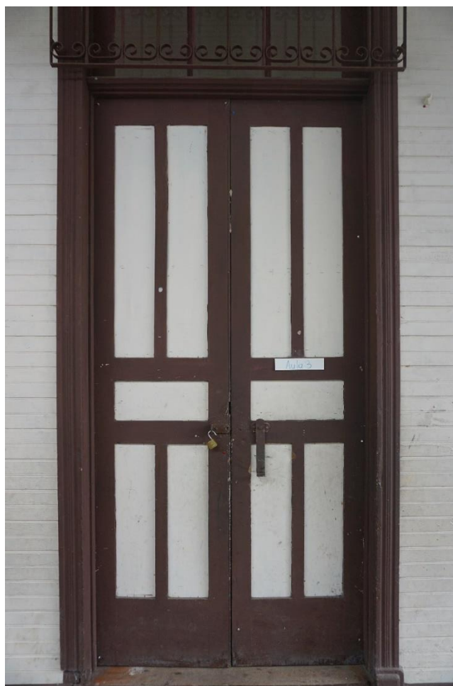
Figura 16. Detalle de puerta
