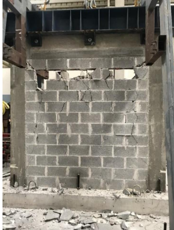
Figura 58. Estado final del muro Fuente: (Sánchez, 2019)
