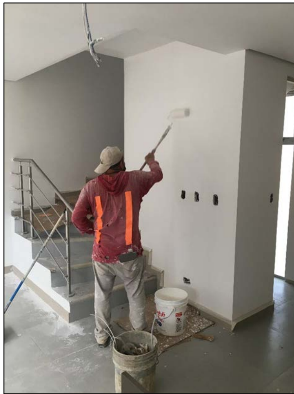
Figura 5. Pintado de paredes en proyecto A
