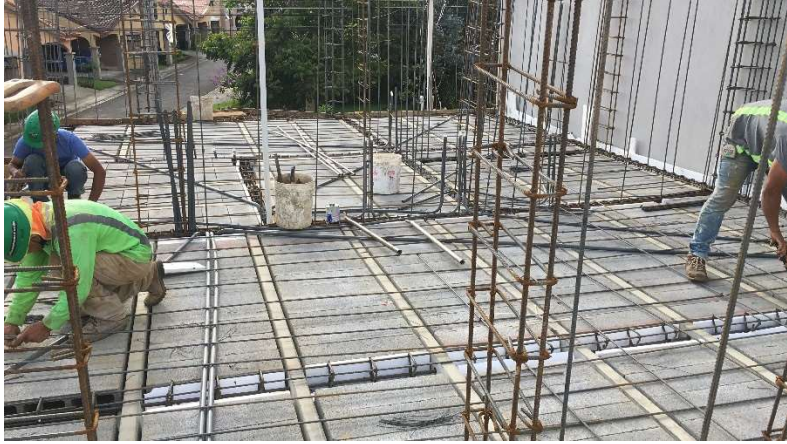
Figura 28. Armado de losa de entrepiso Proyecto C
