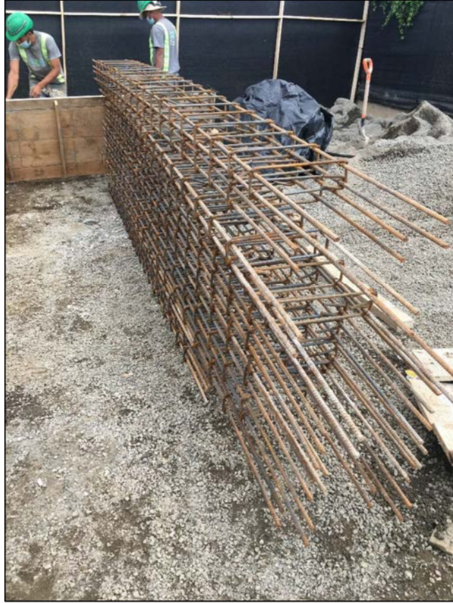
Figura 12. Apilamiento de armaduras en proyecto C
