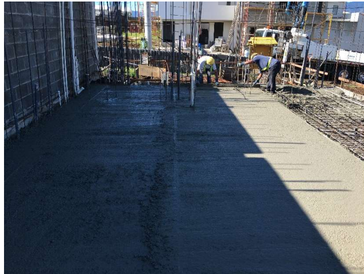
Figura 27. Colado de losa de contrapiso Proyecto D
