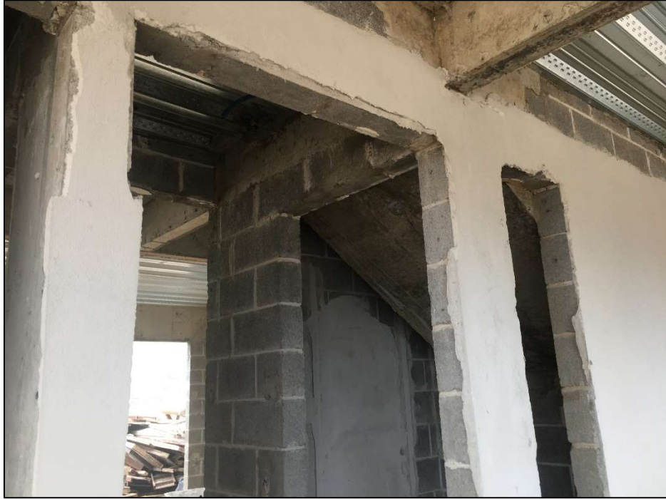
Figura 4. Repello de paredes en proyecto A
