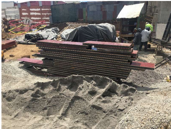
Figura 25. Paneles de formaleta acumulados Proyecto A
