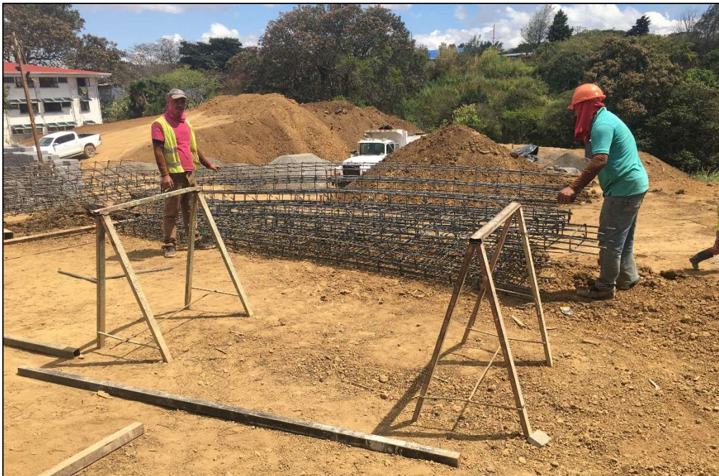
Figura 3. Armado de vigas en proyecto A
