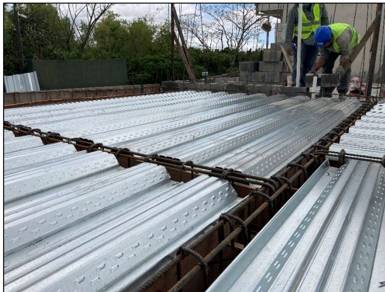
Figura 21. Sistema Metaldeck en proyecto E
