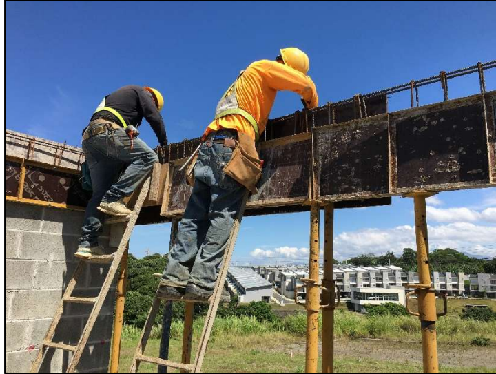
Figura 16. Colocación y refuerzo de formaleta en proyecto D
