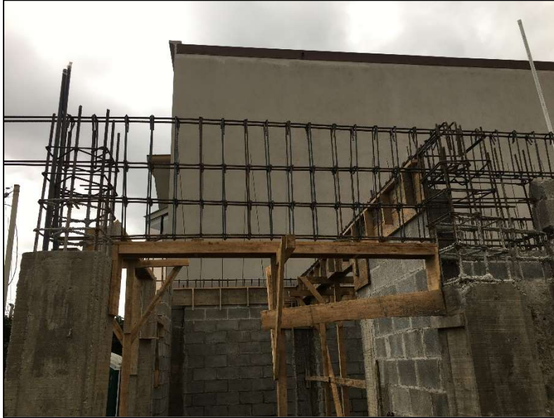
Figura 14. Montado de armaduras en proyecto C
