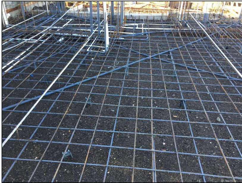
Figura 8. Armado de contrapiso en proyecto B
