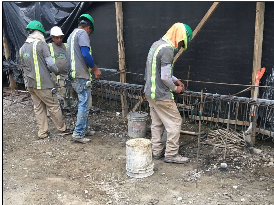
Figura 13. Armado de vigas en proyecto C
