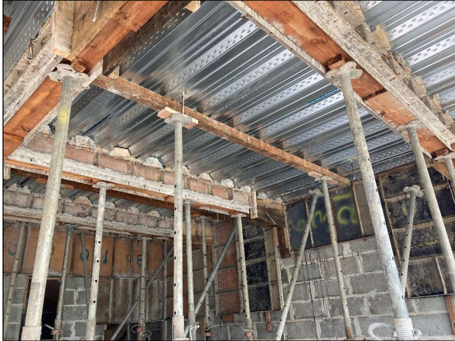
Figura 22. Apuntalado de Metaldeck en proyecto E
