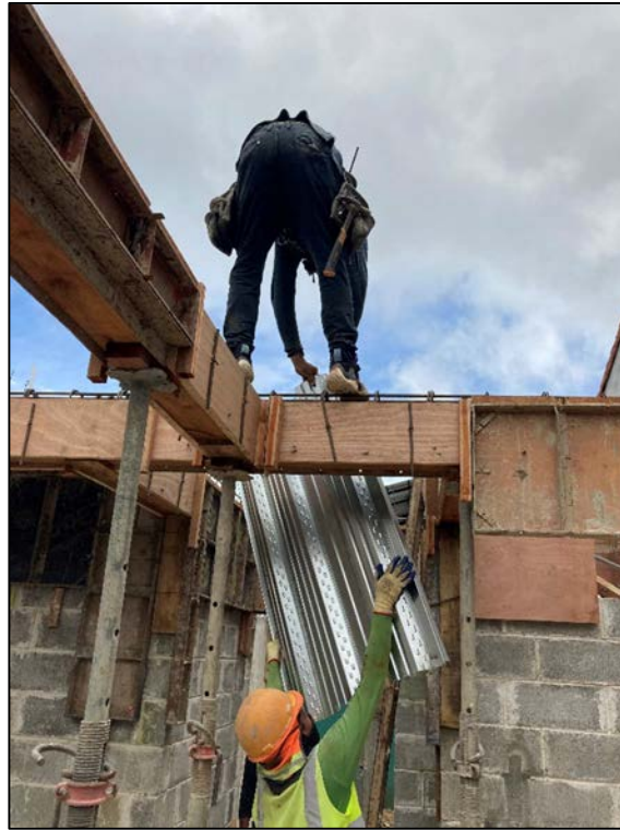
Figura 20. Instalado de láminas de Metaldeck en proyecto E
