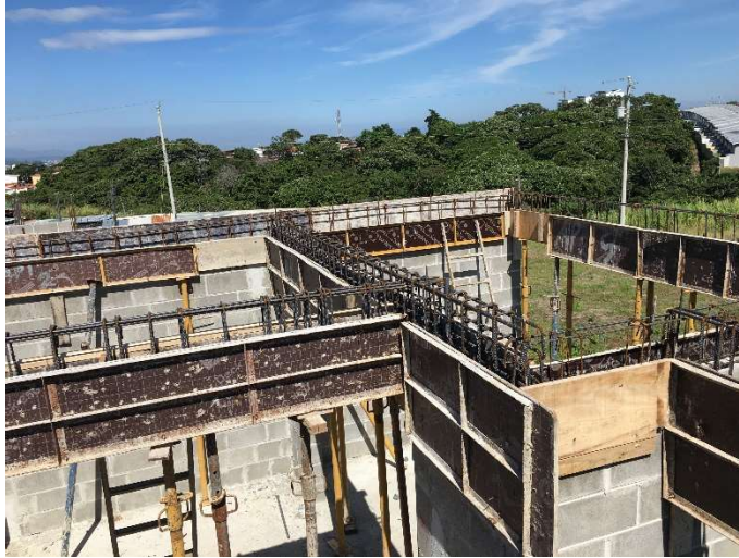
Figura 24. Paneles de formaleta Proyecto D
