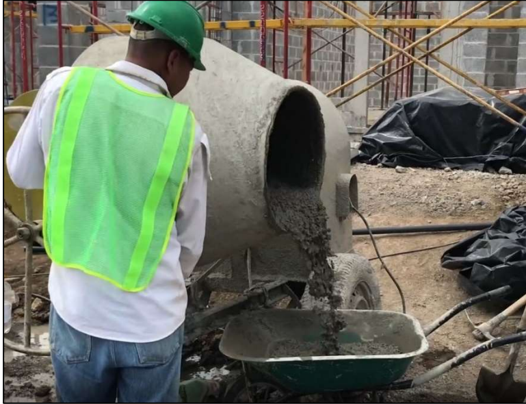
Figura 18. Fabricación de concreto proyecto D
