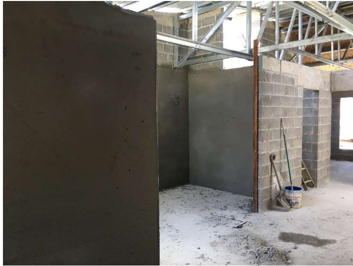
Figura 26. Repello de paredes Proyecto B
