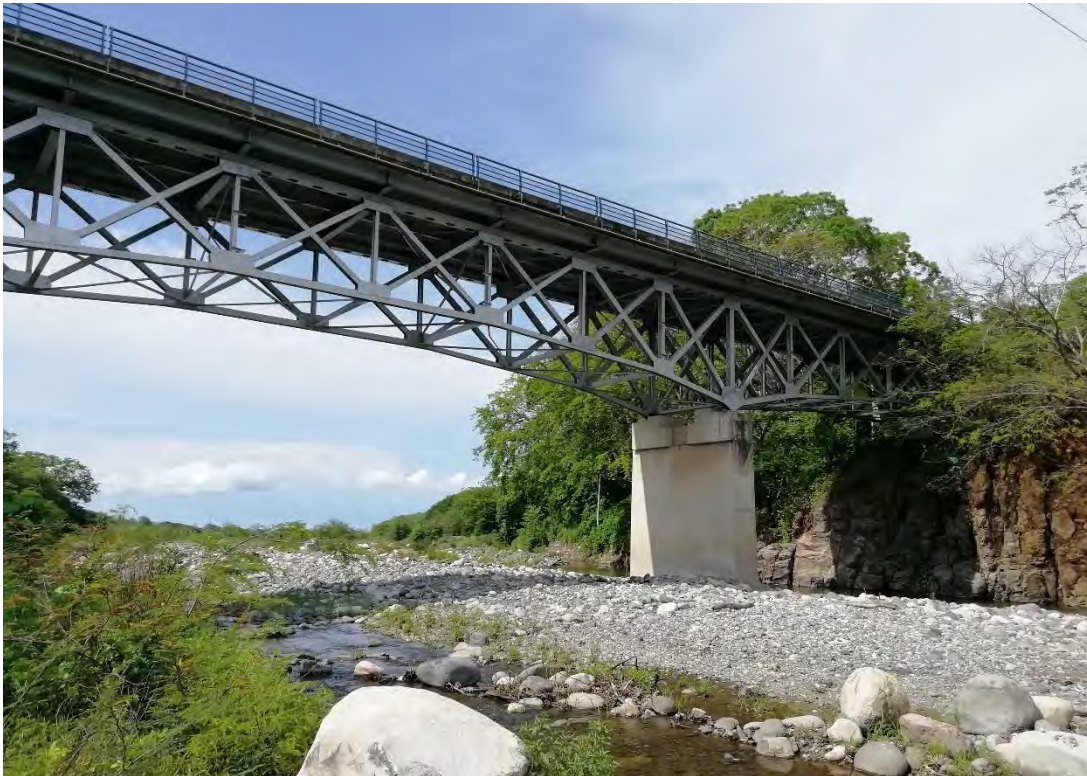
Figura 29. Puente sobre la Ruta Nacional 1
