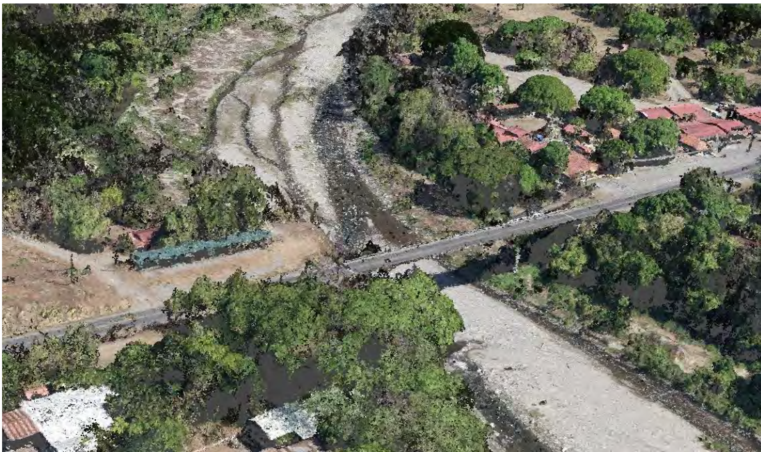
Figura 40. Visualización de la nube de puntos en la zona del puente sobre la Ruta Nacional 1 sobre el río Aranjuez
