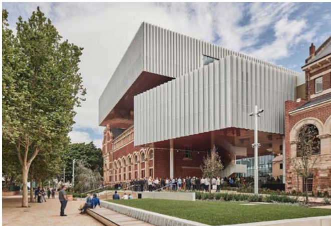
Figura 38. Museo WA Booda Bardip Proyecto de OMA. Referencia para fachada metálica microperforada que permite ver hacia afuera. Imagen tomada de OMA.com Imagen tomada de Arquine.com
