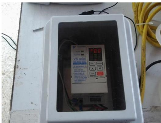
**Figura 8.2** Variador de frecuencia del motor.
