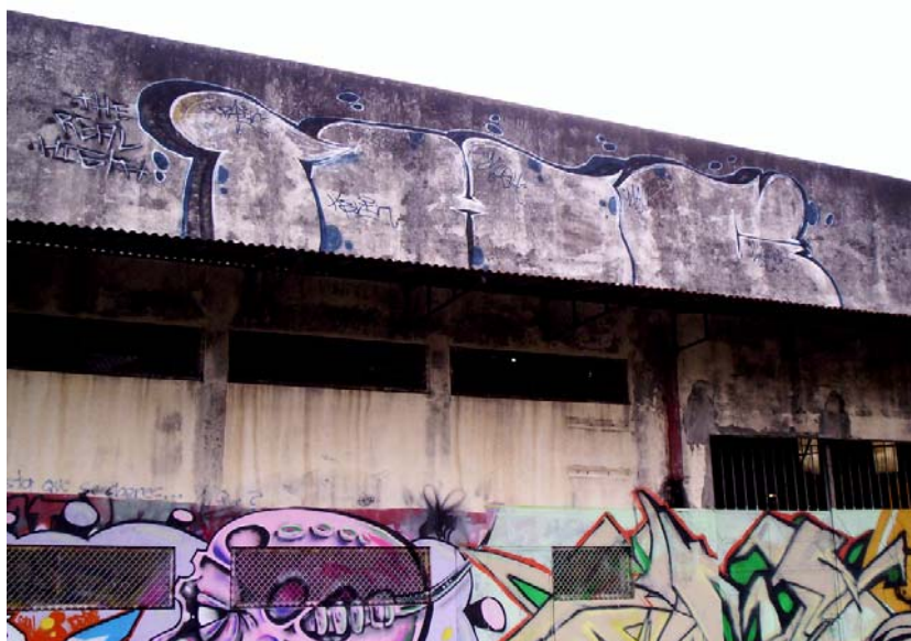
Autores: Pain y Kien Bomba Edificio Saprissa, 15/ 05/08 Foto: Marialina Villegas Zúñiga
