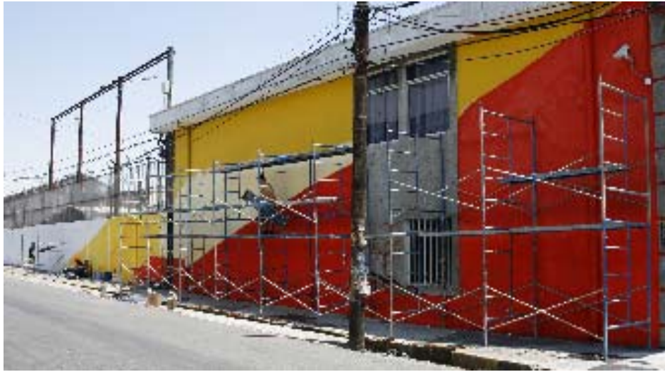
Pintores pasando base Barrio La California, 28/03/09 Foto: Marialina Villegas Zúñiga
