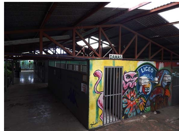
Fig. 4, Batería de Baños Existente, Guillén Rivera, A. (2020)
