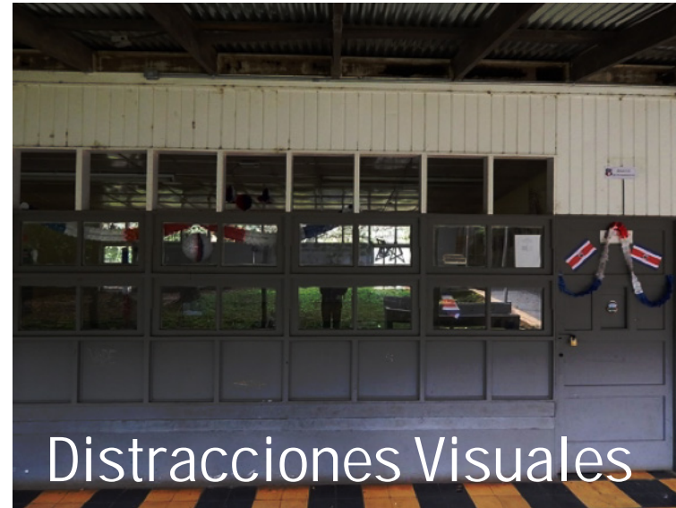
Fig. 23, Frente de Aula Existente, Guillén Rivera, A. (2020)
