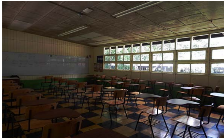
Fig. 5, Interior de Aula Existente, Guillén Rivera, A. (2020)
