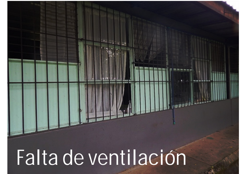
Fig. 24, Fachada Posterior de Aula Existente, Guillén Rivera, A. (2020)
