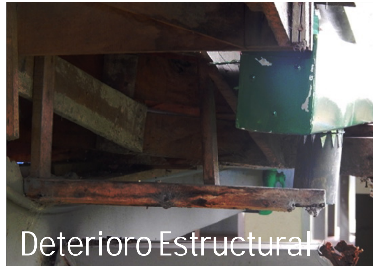
Fig. 25, Detalle de Cercha Existente, Guillén Rivera, A. (2020)
