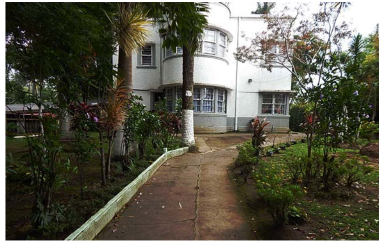
Fig. 3, Edificio de Interés Patrimonial, Guillén Rivera, A. (2020)
