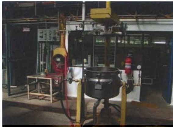
Figura 5. Planta Piloto antes de la remodelación.
